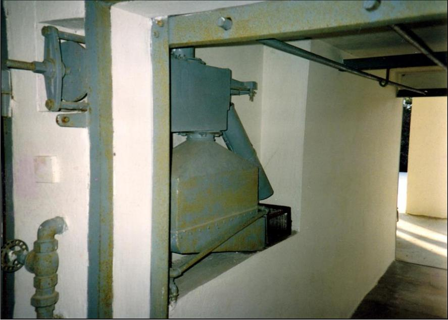
Dokument 46: Degesch-Kreislaufanlage in einer der vier Zyklon-B-Entwesungskammern des Krematoriums Dachau im Jahr 1990. © Carlo Mattogno.
