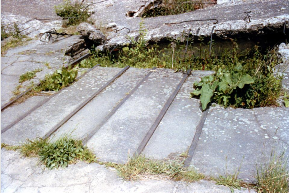
Dokument 9: Drei Schienenpaare für die "Leicheneinführungs-Vorrichtung" im Boden des Ofenraums von Krematorium II in Birkenau, die ursprünglich vor den Öffnungen der Dreimuffelöfen endeten. Mattoigno/Deana, Teil 3, Foto 217, S. 141.
