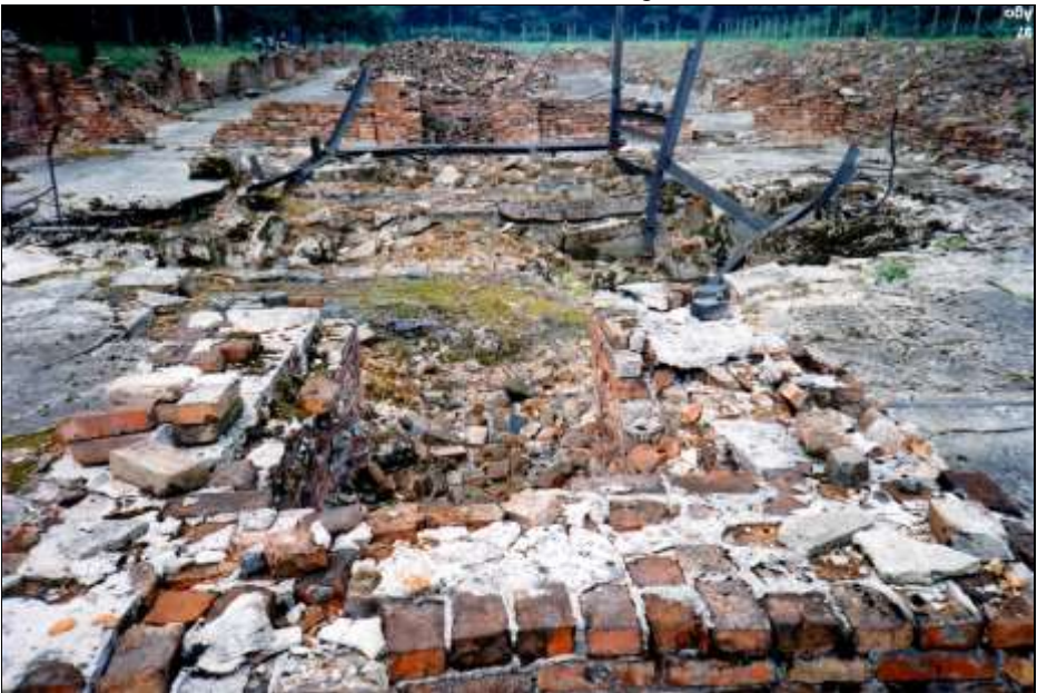
Foto 2: Birkenau, Krematorium V. Überreste des östlichen Kamins, der Ofenverankerung und des westlichen Kamins. © C. Mattogno.
