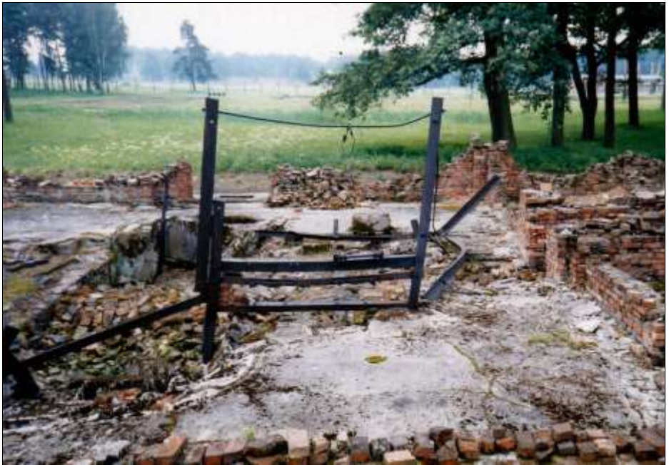
Foto 6: Birkenau, Krematorium V. Überreste der Ofenverankerung und des westlichen Kamins. © C. Mattogno.
