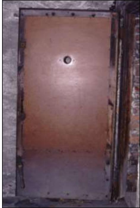
Abbildung 23: Provisorische Luftschutzbunkertür von Krematorium I aus Holz mit einem dünnen Eisenblech, wahrscheinlich von Häftlingen in der Häftlingswerkstatt hergestellt.
