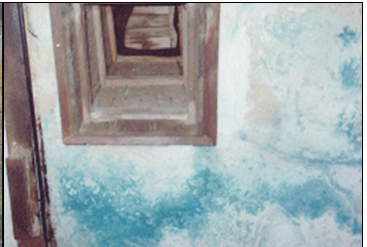
Foto 4: Decke der provisorischen Entwesungskammer im Gebäude "Bad & Desinfektion I" in Majdanek.
