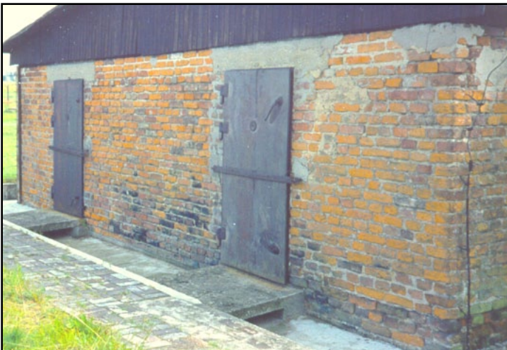
Foto 3: Außenseite einer Mauer der Entwesungsanlage im Lager Majdanek.
