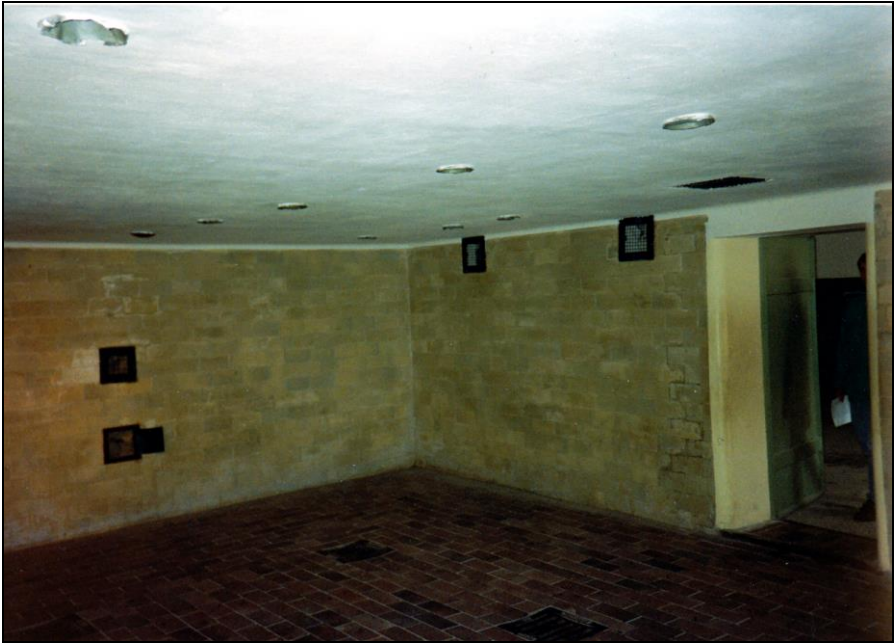
Foto 11: Das Innere der angeblichen Gaskammer von Dachau: Die falsche Decke mit falschen Duschköpfen. Dezember 1990. © Carlo Mattogno.
