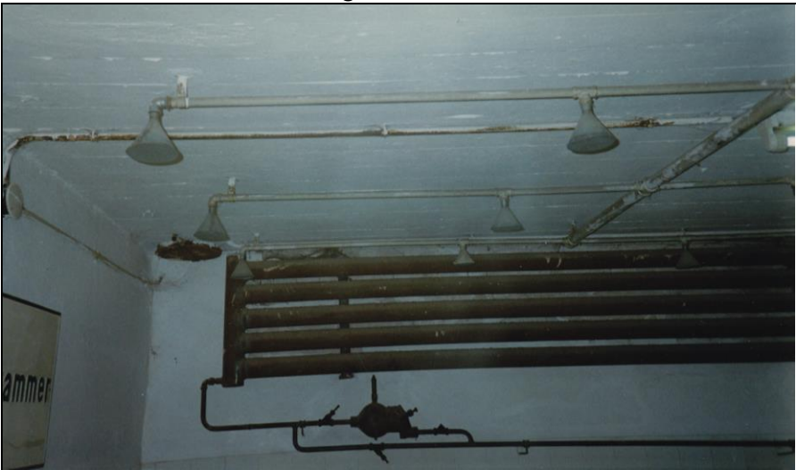
Foto 6: "Gaskammer" von Mauthausen: Duschen und Heizkörper mit 5 Rohren. Dezember 1990. © Carlo Mattogno.
