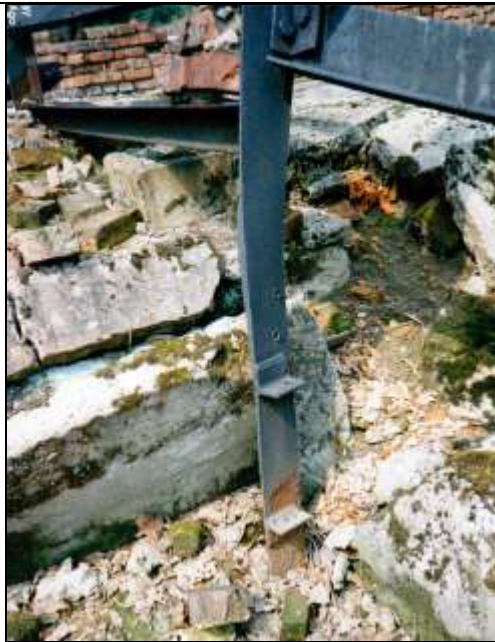
Foto 231: wie zuvor. Detail der Rahmeneisen des nördlichen Generators (von Süd nach Nord). Die Generatorherdtür war an die zwei sichtbaren Winkel-eisen befestigt.
