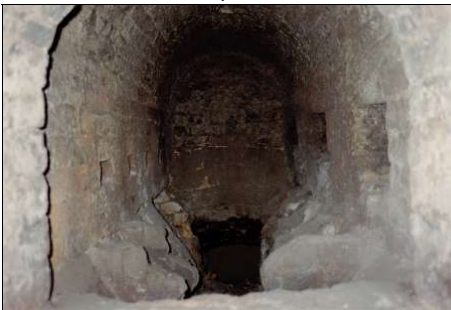
Foto 140: koksbefeuerter Dreimuffelofen, linke Muffel. Linke Wand: quadratische Öffnungen des Verbrennungsluftkanals. Unten: abgeschrägte Wand der Aschenkammer). Mitte rechts: Öffnung zum Generator. Rechte Wand: rechteckige Verbindungsöffnungen. Die Muffelroststäbe wurden herausgerissen.
