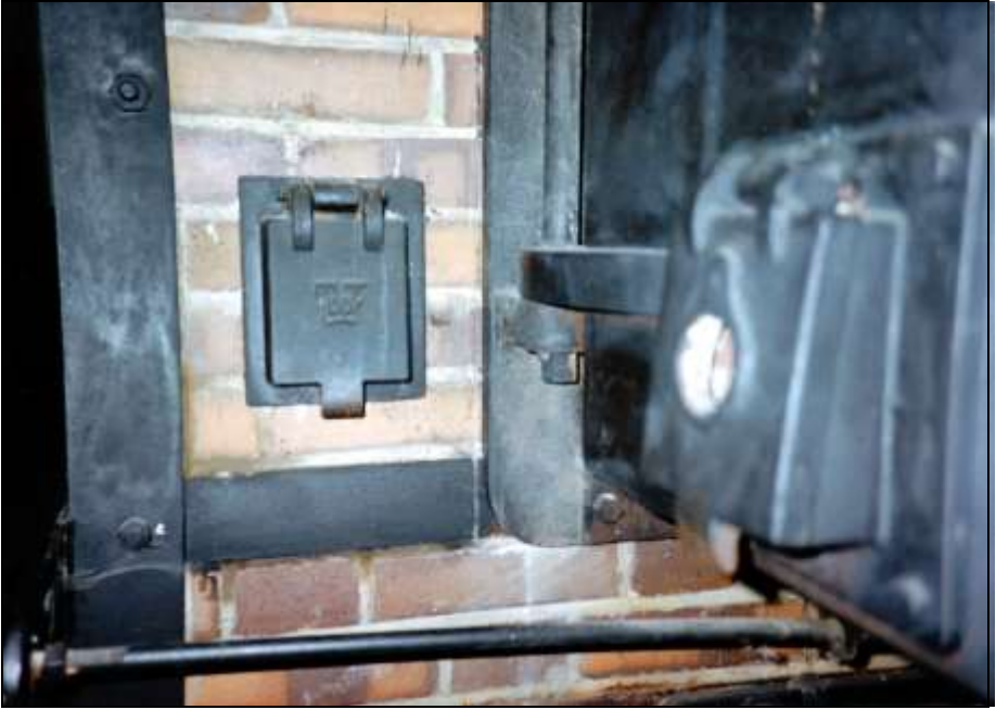
Foto 58: Klappe des Verbrennungsluftkanals der linken Muffel.
