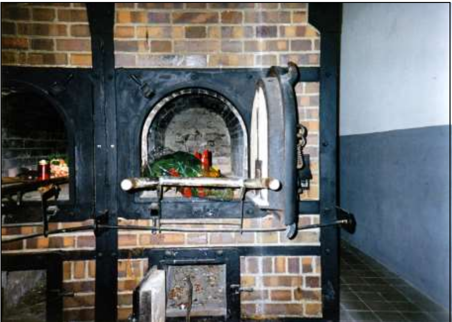
Foto 83: Einführsystem der rechten Muffel: an den Ofenrahmen befestigtes Rundeisen, verschiebbarer Laufrollenrahmen und Leicheneinführtrage.
