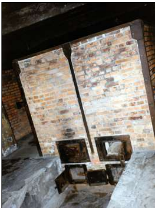
Foto 97: Ofen Nr. 1, Rückseite. Die Öfen wurden ohne Generatoren rekonstruiert. Die Koksfülltüren der Generatoren sind daher zwangsweise an der falschen Stelle über den Aschenkammertüren. Siehe Foto 78.
