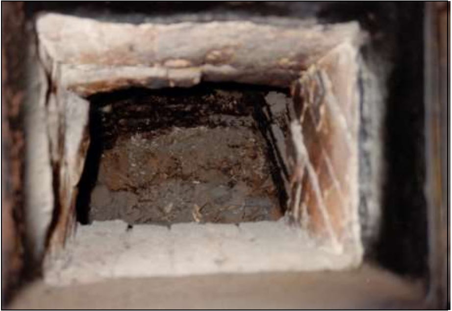
Foto 163: wie zuvor, Blick durch den Generatorfüllschacht in den Generator.
