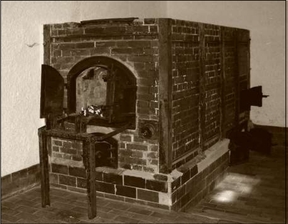
Foto 335: KORI, koksbefeuerter Kremierungssofen im KL Flossenbürg.
