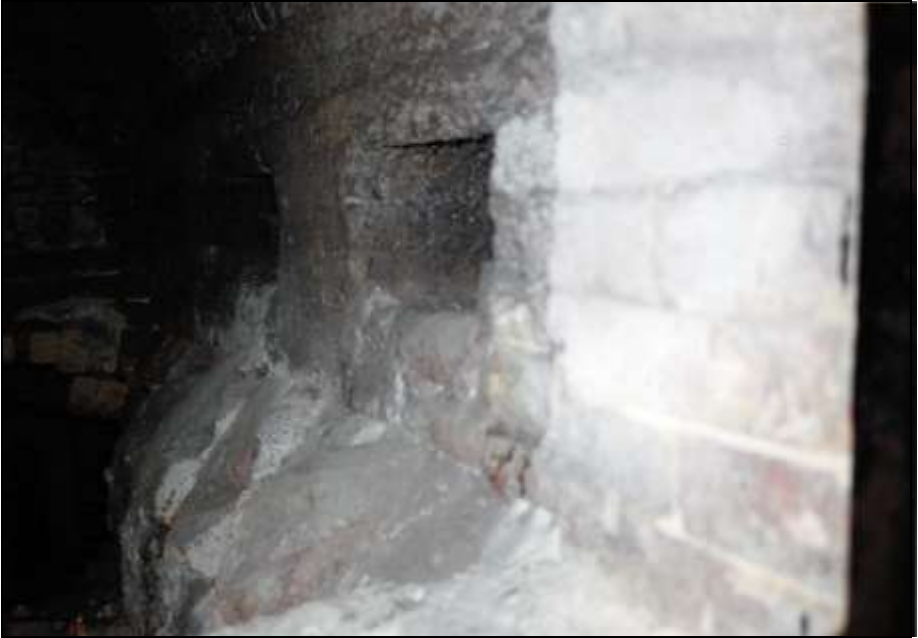
Foto 134: wie zuvor, rechte Muffelwand der rechten Seitenmuffel mit rechteckigen Verbindungsöffnungen zur mittleren Muffel.
