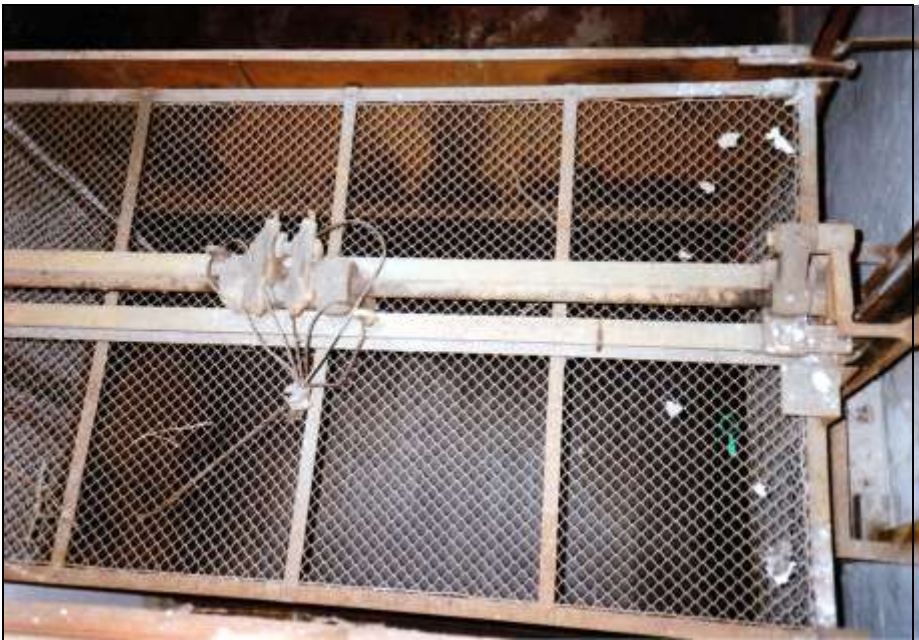
Foto 215: wie zuvor; Blick von oben aus der Kremierungshalle auf den Lastenaufzug.
