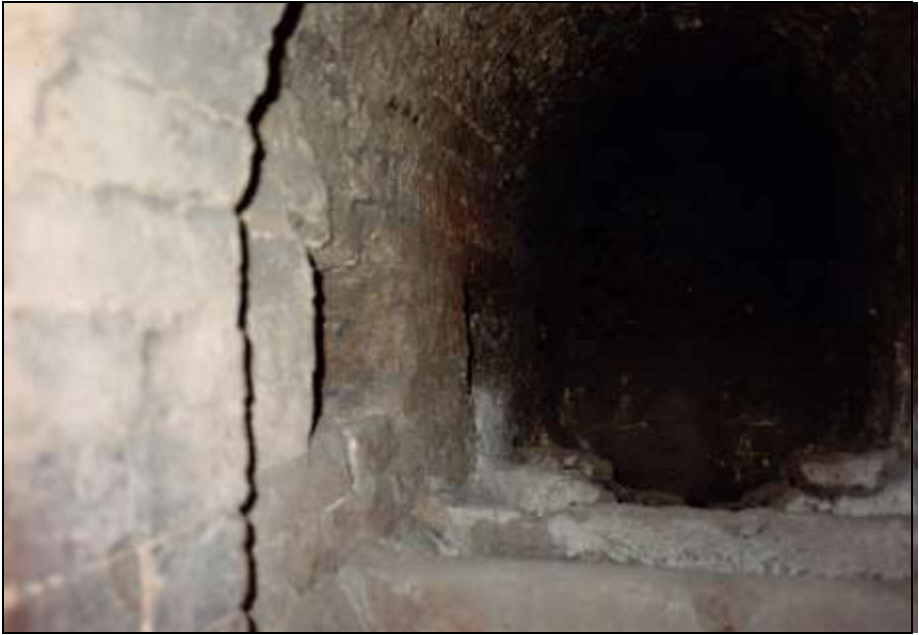
Foto 145: wie zuvor, rechte Muffel, linke Wand mit rechteckigen Öffnungen zur mittleren Muffel.
