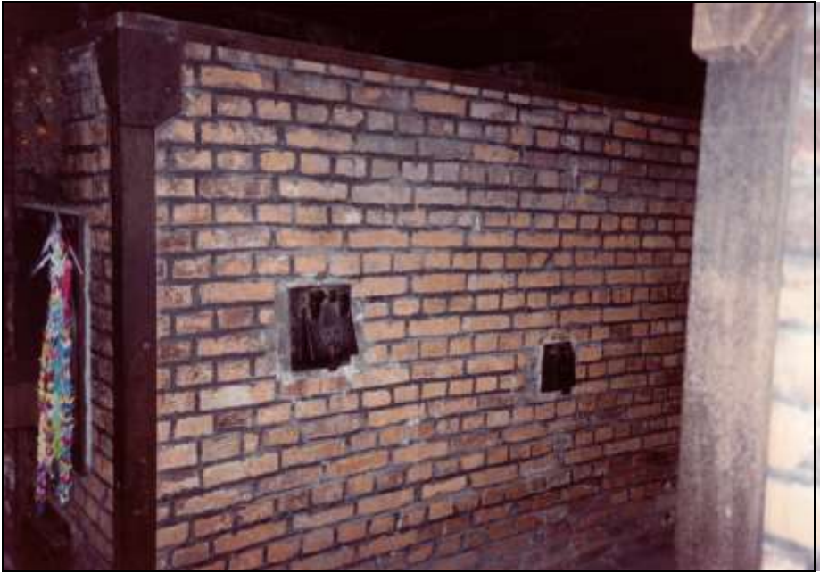
Foto 96: Ofen Nr. 1, rechte Seite. Ursprünglich Klappen der Verbrennungsluftkanäle. Die polnischen Rekonstruktionen enthalten diese Kanäle nicht. Auch die Anzahl, Art und Lage der Klappen sind falsch. Die größere Klappe gehörte ursprünglich zu einem Achtmuffelofen, und die kleinere Tür befand sich weiter unten. Vgl. Foto 73.
