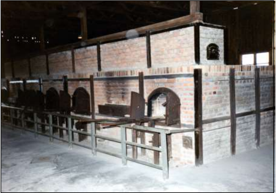
Foto 309: Vorderansicht von der rechten Seite. Die Backsteinstruktur oben enthält den Rauchkanal, mit einer Reinigungstür an der Seite.
