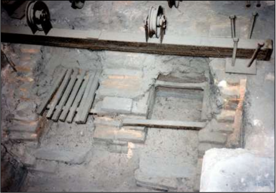
Foto 101: wie zuvor, von hinten betrachtet: ursprünglicher Herdrost des linken Generators und die zwei Querstäbe des rechten Rostes. Die Stange mit den Rollen, die ursprünglich an der Decke befestigt war, diente zur Betätigung der beiden Rauchkanalschieber des Ofens.
