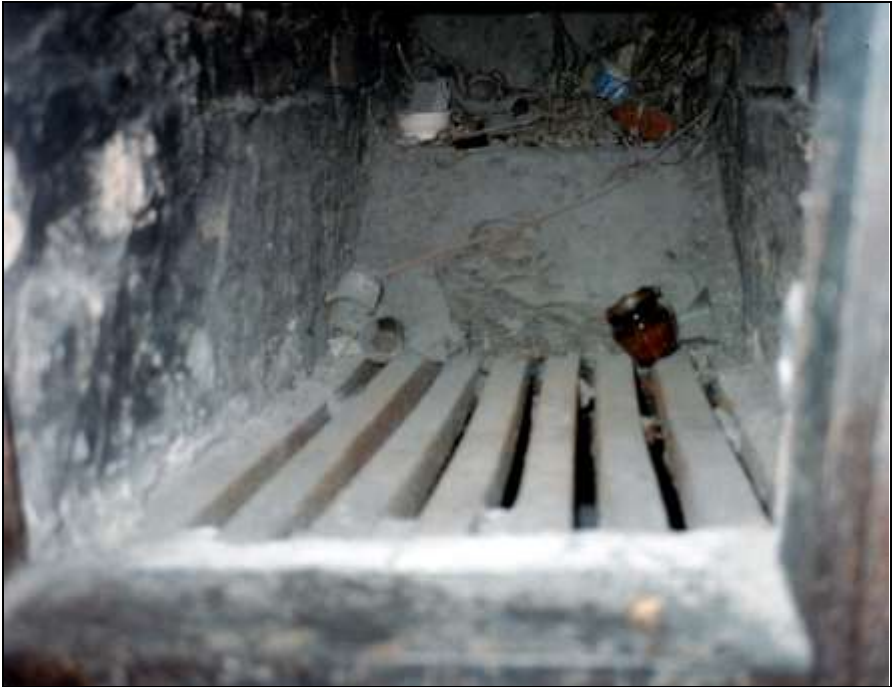
Foto 99: Ofen 2: ursprünglicher Generatorrost mit sieben Vierkanteisen und zwei Auflagereisen quer dazu.
