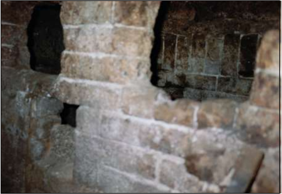
Foto 20: Linke Muffel: Trennwand mit Verbindungsöffnungen zwischen den Muffeln.
