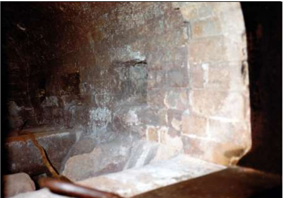
Foto 138: wie zuvor, rechteckige Verbindungsöffnungen in der rechten Muffelwand.
