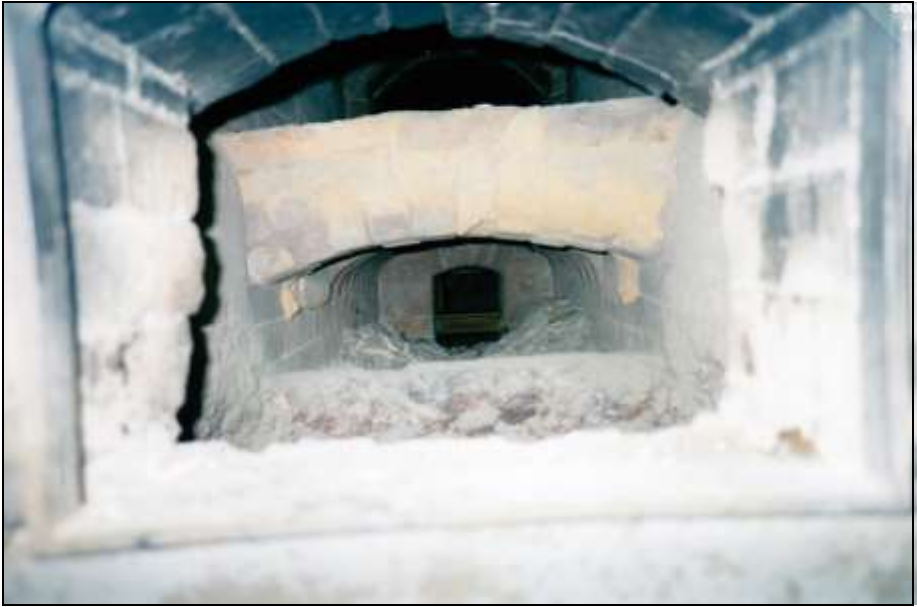
Foto 313: Das Innere eines Ofens, durch die Koksfülltür des Generators betrachtet. Vordergrund: der Generator; dahinter: die Aschenkammer mit der Aschentür im Hintergrund; darüber: Schamottrost der Muffel; oben: die Muffel.
