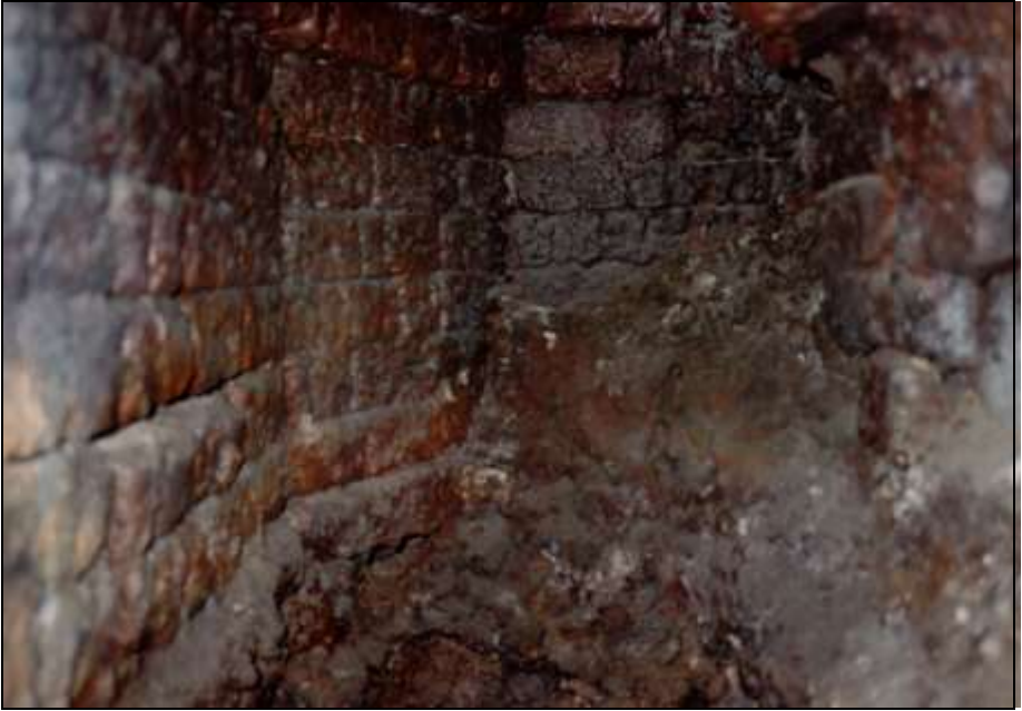
Foto 315: Das Innere des Generators des TOPF-Ofens im KL Gusen. Das Schamottmauerwerk zeigt deutliche Sinterspuren.
