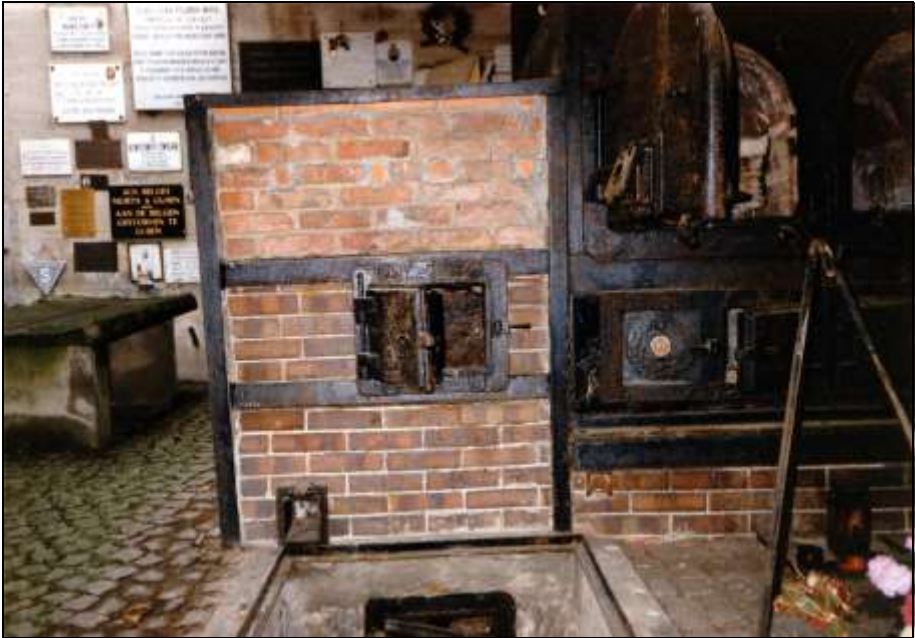
Foto 4: Des Ofens linker Generator mit Koksfülltür und des Generators Primärluft-Zutrittsöffnung (mit fehlender Klappe).
