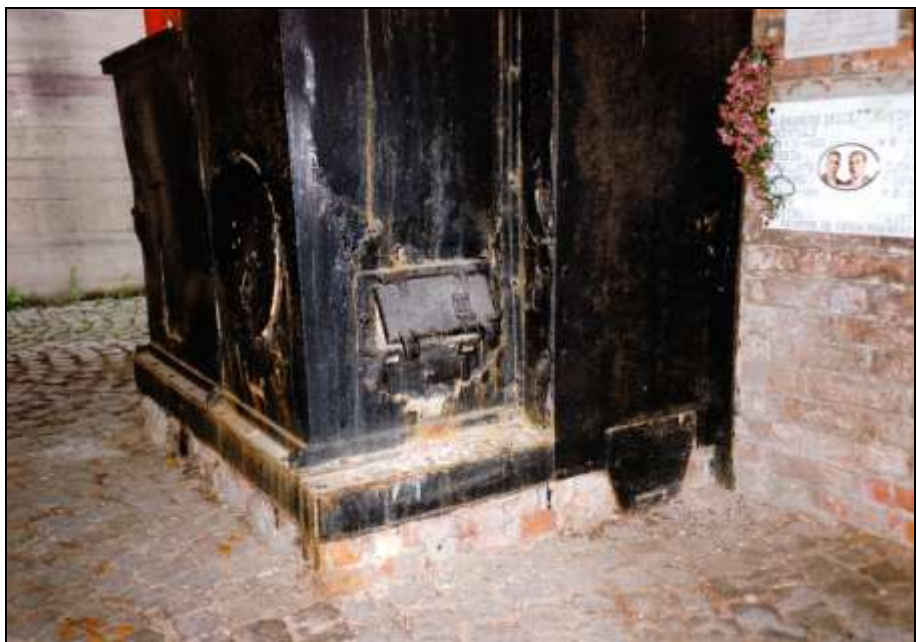
Foto 34: Rückseite des Ofens mit Kamin (linke Seite) mit Zugriffstür zum Lockfeuer am Kaminboden. Das runde Blech, das an den Schornsteinsockel geschweißt ist, verschließt die ursprüngliche Öffnung für ein Saugzuggebläse.
