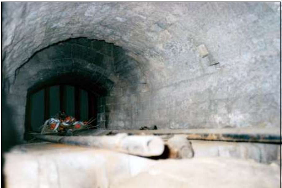
Foto 279: Inneres der Muffel, durch die Koksfülltür des Hauptgenerators betrachtet. In der rechten Wand: Öffnungen für die Verbrennungsluftversorgung. Oben im Hintergrund: die Öffnung des Abgaskanals.
