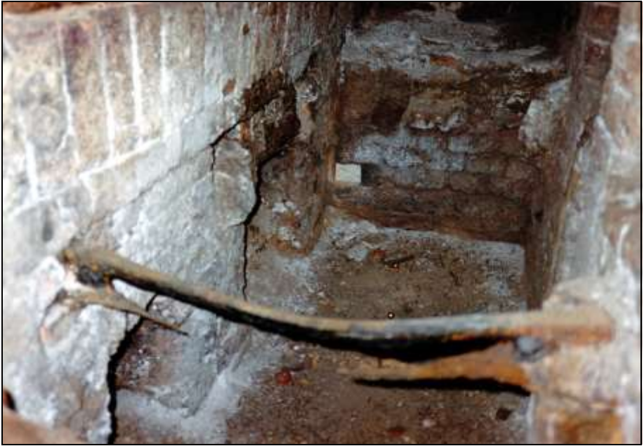
Foto 16: Linke Muffel: Aschenraum mit zwei Öffnungen, die ihn mit dem Generator verbinden.
