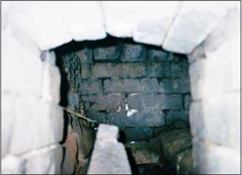
Foto 281: wie zuvor. Blick in den Hilfsgenerator. Hintergrund: die Wand der Muffel-Aschenkammer. Vordergrund: das Ende eines Vierkanteisens des Feuerungsrostes des Hilfsherds.
