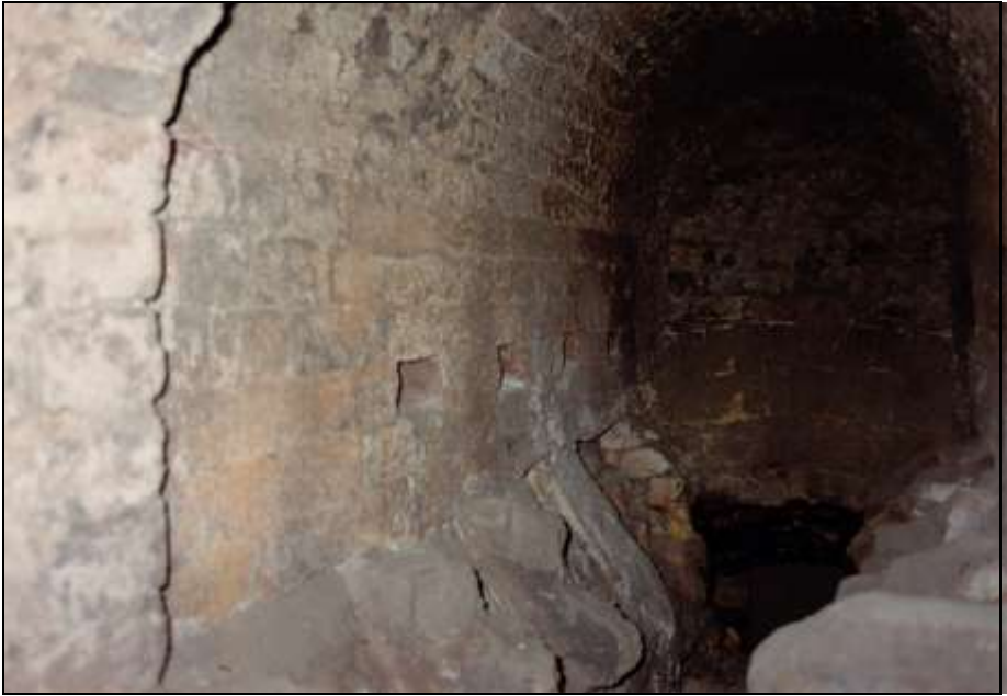
Foto 141: wie zuvor, linke Muffelwand mit Abschrägung zur Aschenkammer; unten rechts die Öffnung zum Generator.
