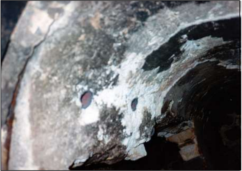
Foto 42: Gewölbte Decke der rechten Muffel; links: Austritte von Rohren, die an das Gebläse angeschlossen sind.
