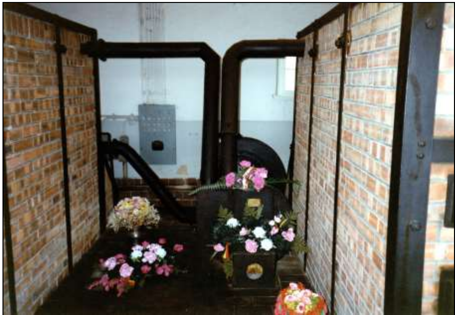
Foto 188: Druckluftgebläse zwischen den zwei Öfen.
