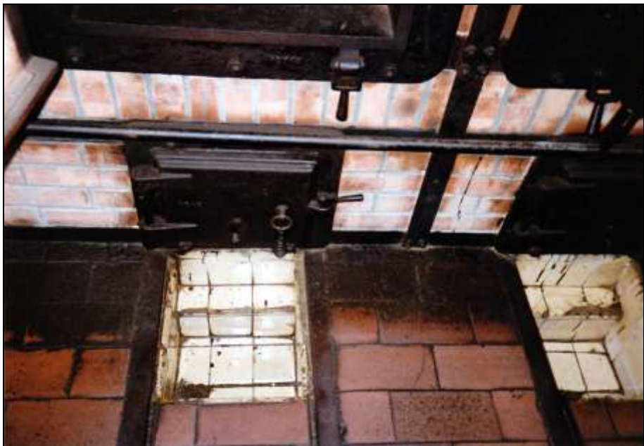
Foto 155: koksbefeuerter TOPF-Dreimuffel-Kremierungssofen. Wartungsgruben an der Vorderseite mit den Aschentüren der linken und mittleren Muffel.
