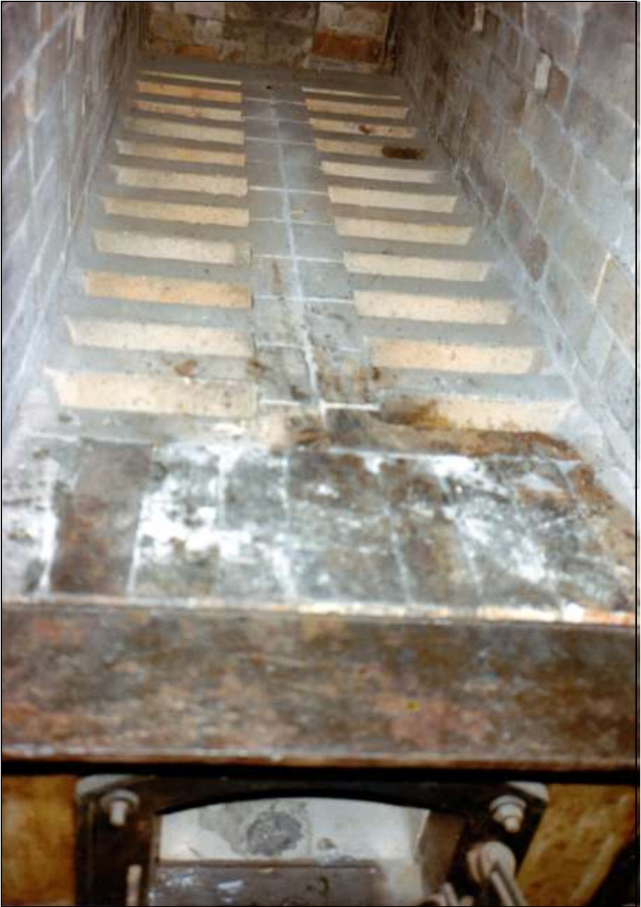
Foto 322: wie zuvor; Schamottrost; unten: Aschentür.
