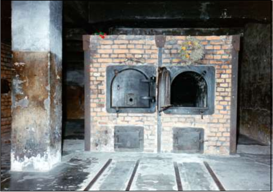
Foto 90: Ofen Nr. 2. Bei der Rekonstruktion wurde das Rundeisen für den Laufrollenrahmen weggelassen sowie die Verbrennungsluftklappen neben den Muffeltüren; zudem wurden die Muffeltüren vertauscht. Vgl. Foto 51.
