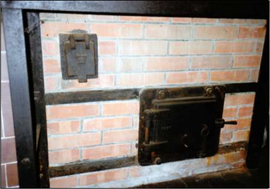
Foto 173: wie zuvor, rechte Muffel. Aschentür des Generators (unten) und die Klappe des Verbrennungsluftkanals zum Generator (oben links).
