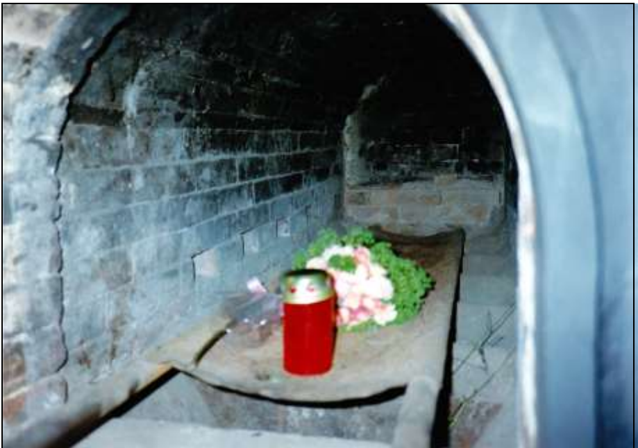
Foto 52 & 53: Linke Muffel. An der linken Muffelwand sind vier Zutrittslöcher für die Verbrennungsluft. Unter der Leichentrage sind die Roststäbe sichtbar.
