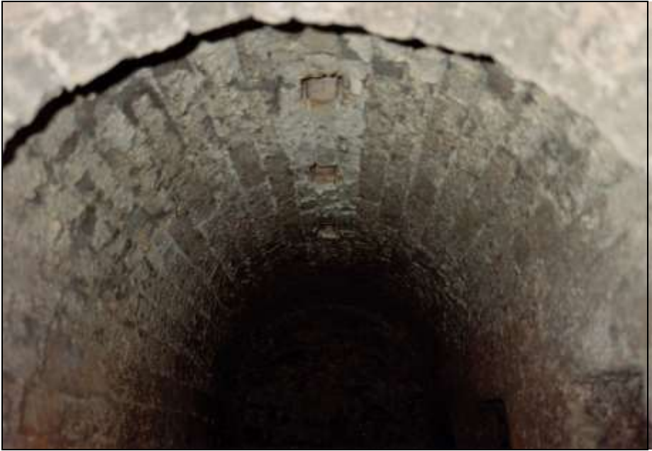
Foto 143: wie zuvor, gewölbte Muffeldecke mit quadratischen Öffnungen für die Verbrennungsluftversorgung.
