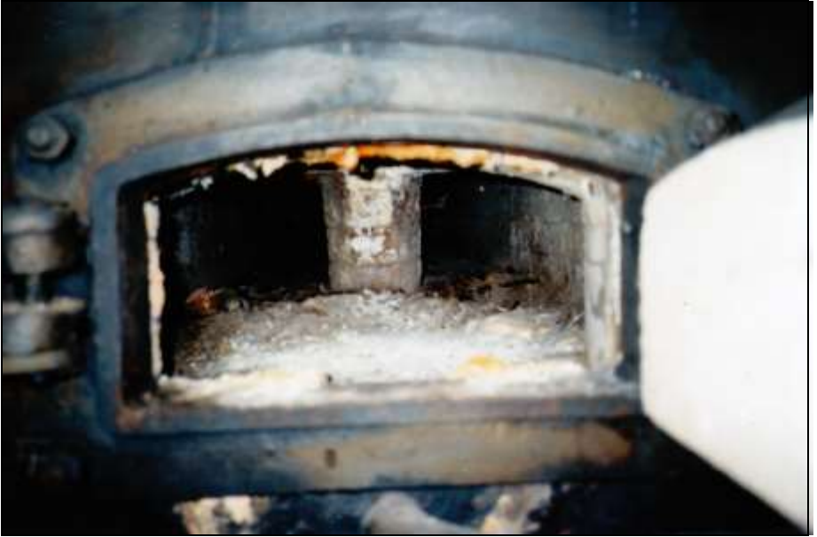
Foto 354: wie zuvor; das Innere nach Nachbrennkammer, durch die hintere Reinigungstür betrachtet.
