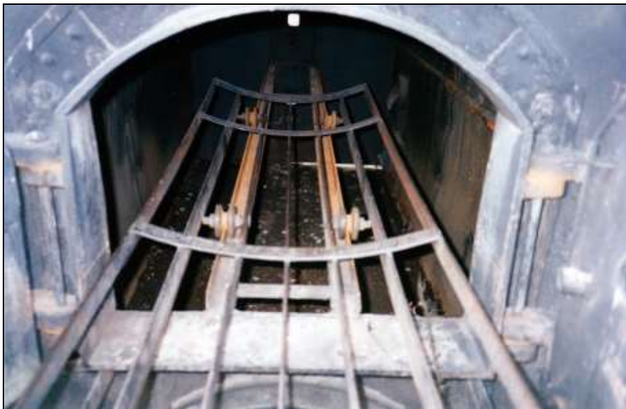
Foto 334: Interior. Die Leicheneinführtrage bewegte sich auf vier Rollen auf zwei Profileisen. In der Öffnung in der Rückwand saß einst der Hauptbrenner. Die Schamottauskleidung wurde vollständig entfernt.
