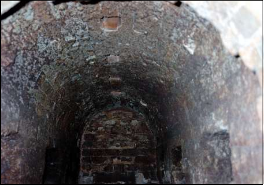
Foto 137: wie zuvor, mit fünf der rechteckigen Verbindungsöffnungen, vier quadratischen Öffnungen in der Decke und einer in der Rückwand zur Versorgung mit Verbrennungsluft.
