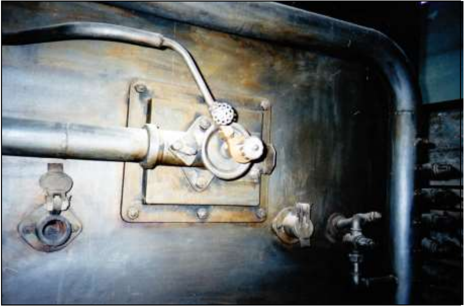
Foto 350: Rechter Ofen des vorderen Paares, Rückansicht, Ölbrenner.
