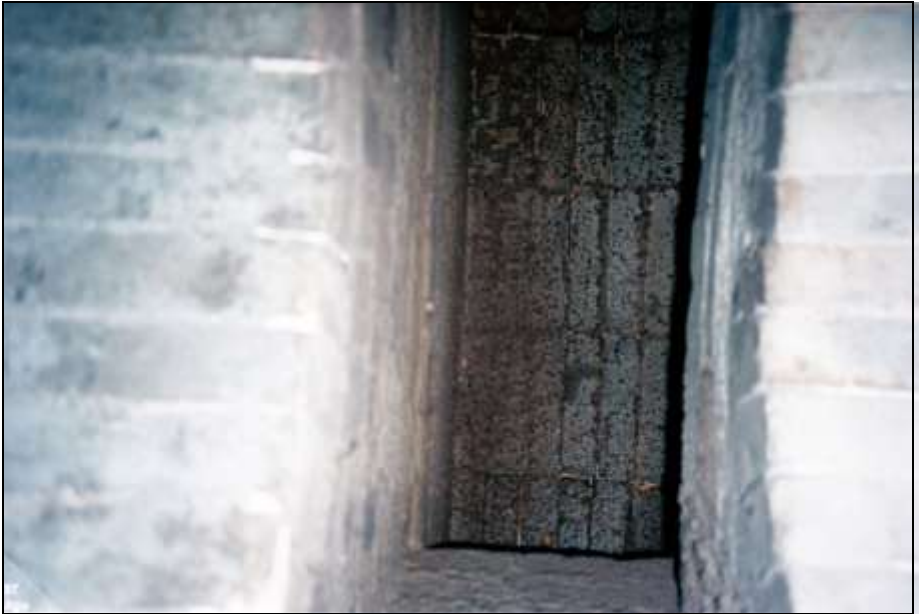
Foto 302: Vertikaler Abgaskanal.
