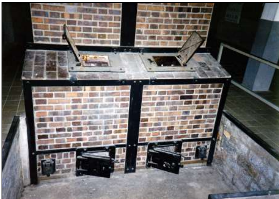
Foto 78: Rückseite des Ofens mit den Generatoren mit Füllschachtverschlüssen (oben), Aschentüren (große Tür unten Mitte) und den Verbrennungsluftklappen (unten, kleine Türen).
