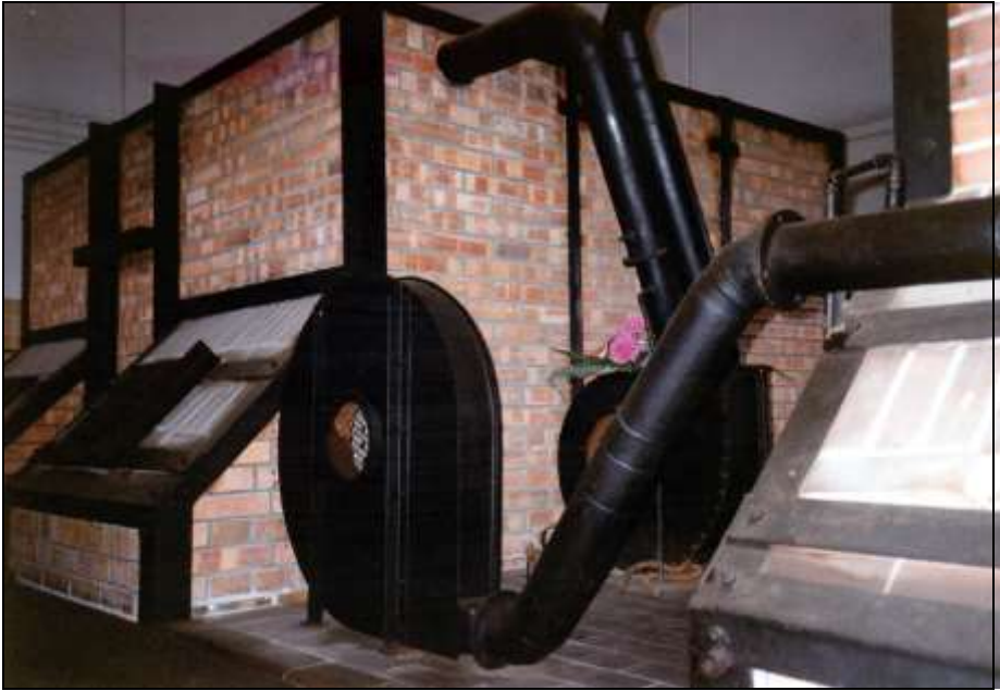
Foto 197: wie zuvor, rechte Rückansicht, mit dem Verbrennungsluftgebläse im Hintergrund.
