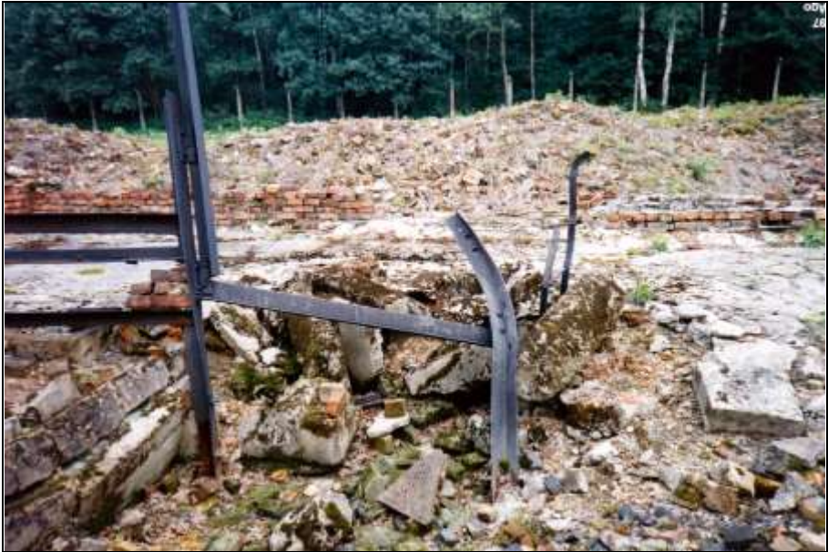
Foto 230: wie zuvor; hinter dem Eisenrahmen: Leiter in die Wartungsgrube des Generators.
