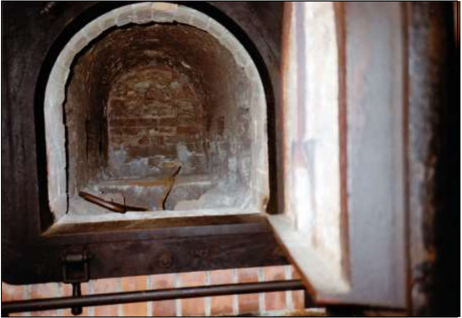
Foto 135: wie zuvor, mittlere Muffel. Beide Seitenwände haben drei Verbindungsöffnungen zu den Seitenmuffeln.
