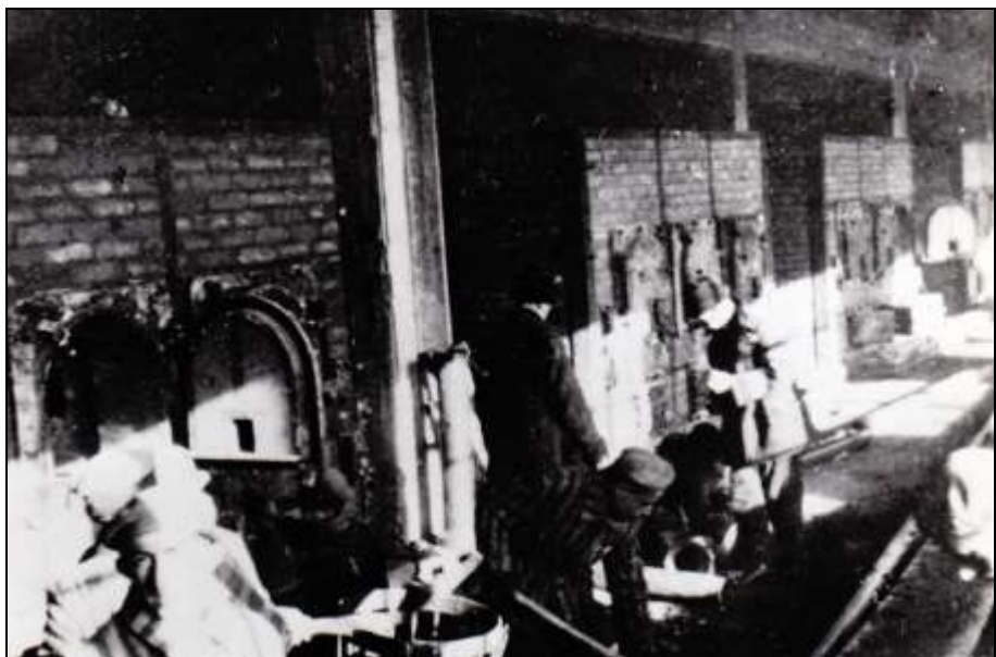
Foto 113: SS-Foto der koksbeheizten TOPF-Dreimuffelöfen im Krematorium II in Birkenau. APMO, Mikrofilm Nr. 290.
