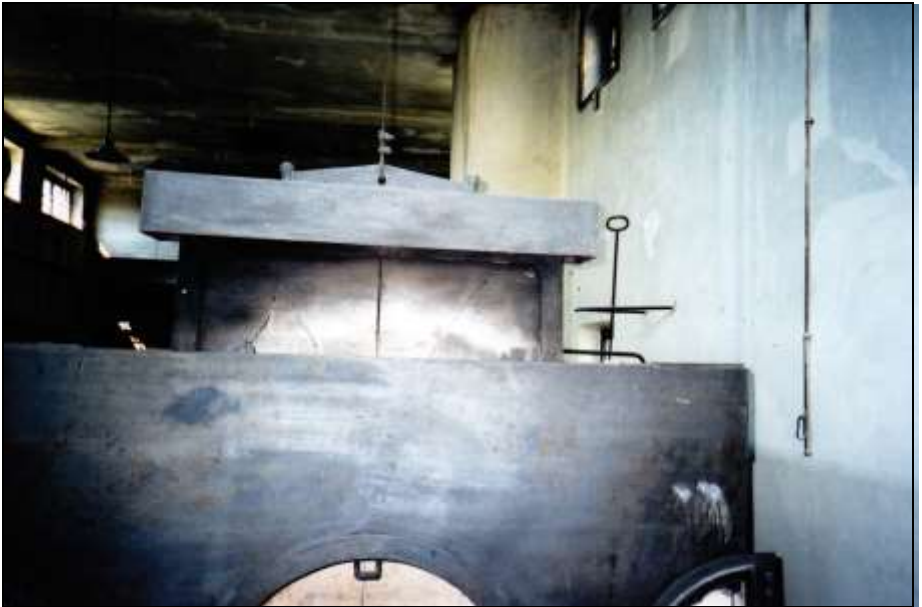
Foto 359: Muffelabsperrschieber des rechten Ofens des hinteren Ofenpaares.
