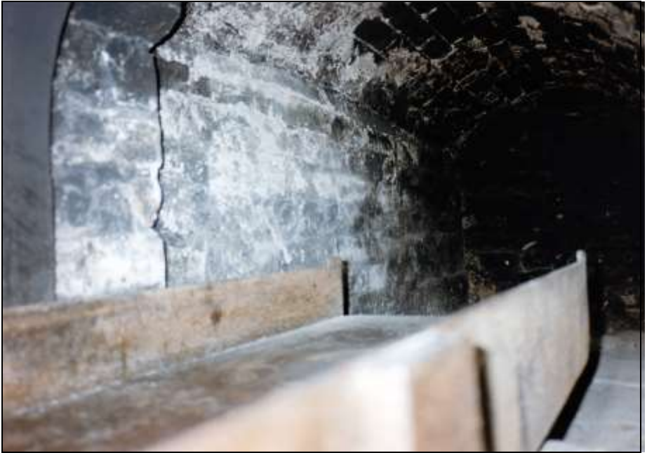
Foto 92: Ofen Nr. 1: Das Muffelinnere. Das Mauerwerk wurde künstlich geschwärzt.
