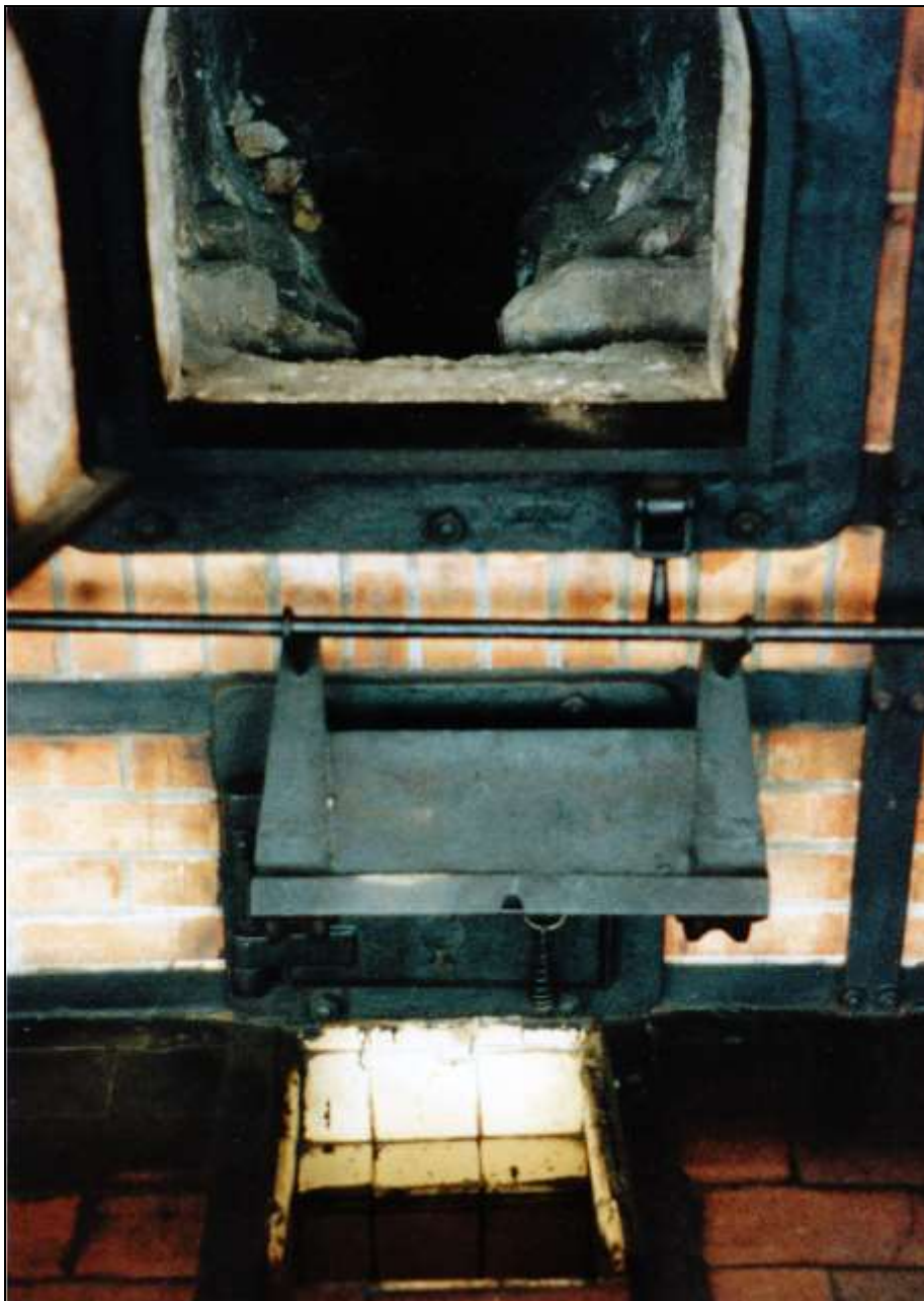
Foto 178: wie zuvor, Vorderansicht, mittlere Muffel. Der abgesenkte bewegliche Laufrollenrahmen. Der Rahmen ist durch ein Befestigungs-Eisen gefädelt, kann vertikal schwenken und horizontal verschoben werden.
