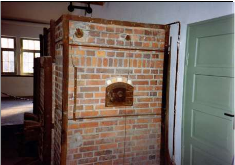
Foto 259: Rückansicht des ersten Ofens; Reinigungstür des Rauchkanals. Drahtseil und Umlenkrollen zur Bedienung des Rauchkanalschiebers, sichtbar in Foto 258 im Boden am unteren Ende des Ofens.
