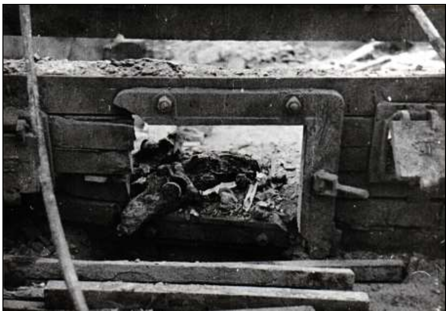
Foto 227: wie zuvor, Rahmen der Aschenkammertür der Muffel in der nordwestlichen Ecke. Rechts sichtbar ist die Klappe des Verbrennungsluftkanals der Aschenkammer.
