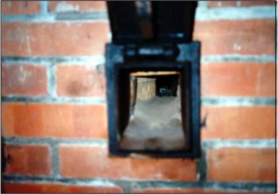
Foto 171: wie zuvor; Nahaufnahme des Verbrennungsluftkanals zur Aschenkammer.
