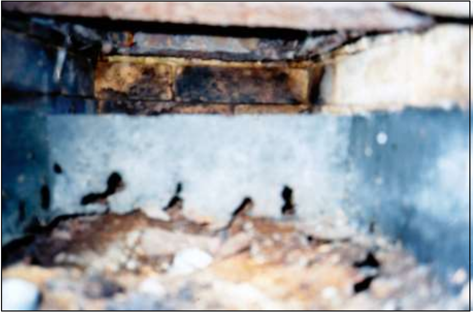
Foto 355: wie zuvor; das Innere der Aschenkammer, betrachtet durch die hintere Aschenentnahmetür mit verrostetem Aschekasten.
