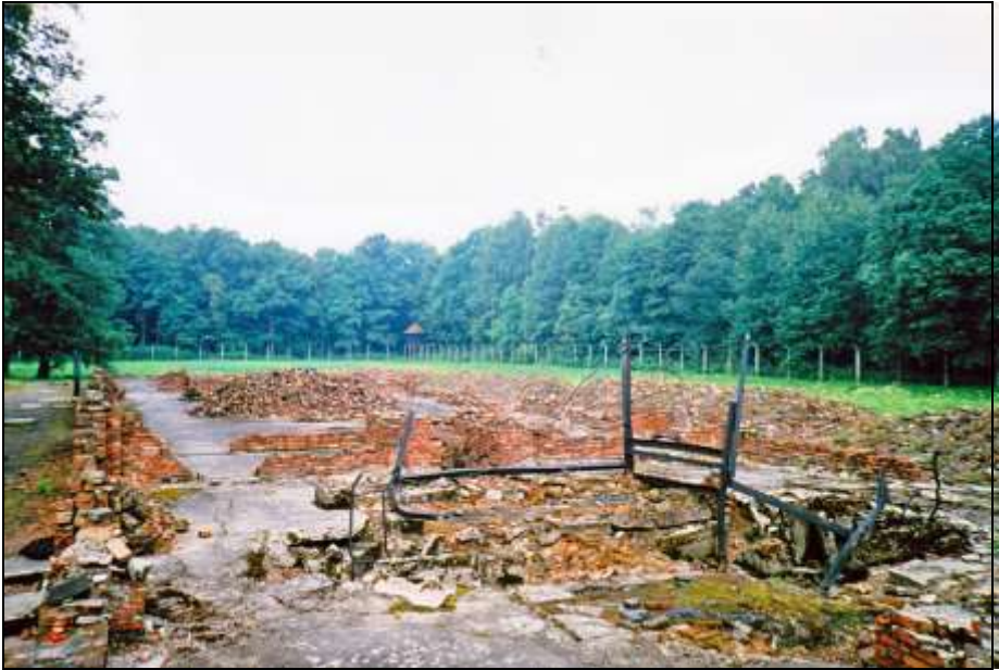
Foto 228: Trümmer von Krematorium V (1997). Gusseiserner Rahmen des TOPF-Achtmuffelofens (von West nach Ost).
