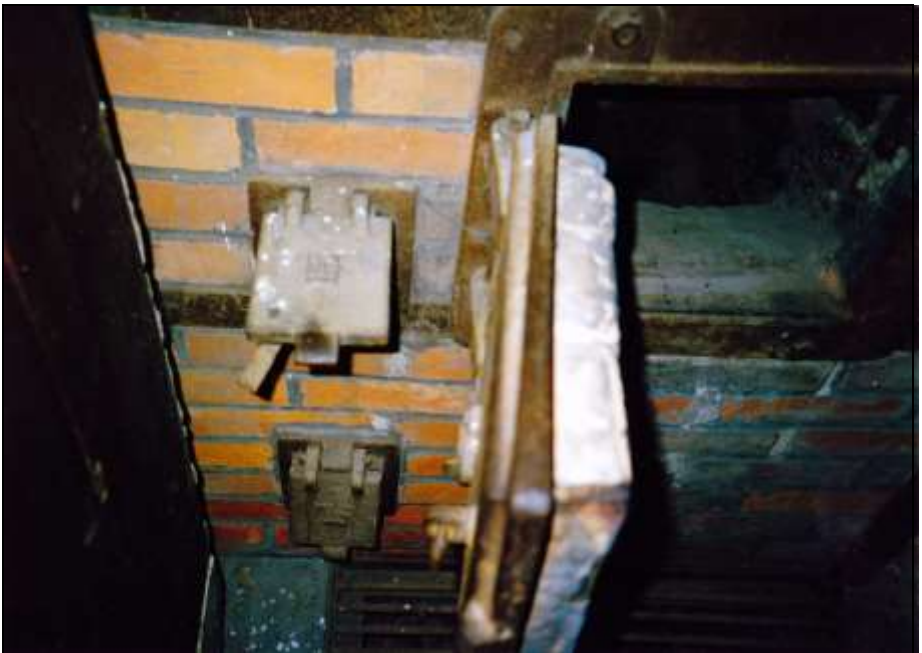
Foto 39: Linker Generator: große Koksfülltür (rechts), kleine Klappe für die Primärluft des Herdes (unten) und für die Primärluft des Generators (oben).
