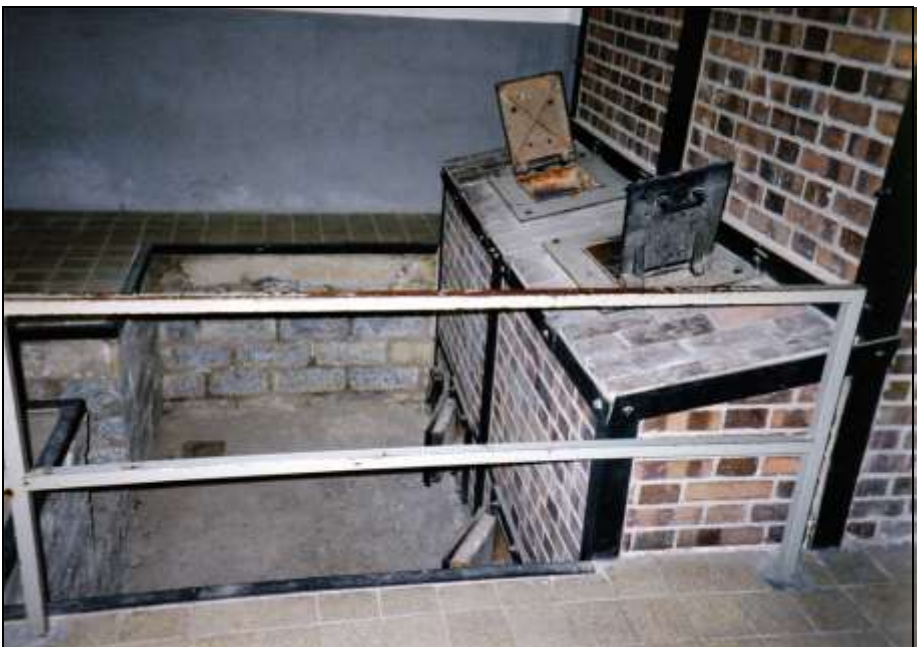
Foto 77: Rückseite des Ofens mit den Generatoren und der Wartungsgrube.
