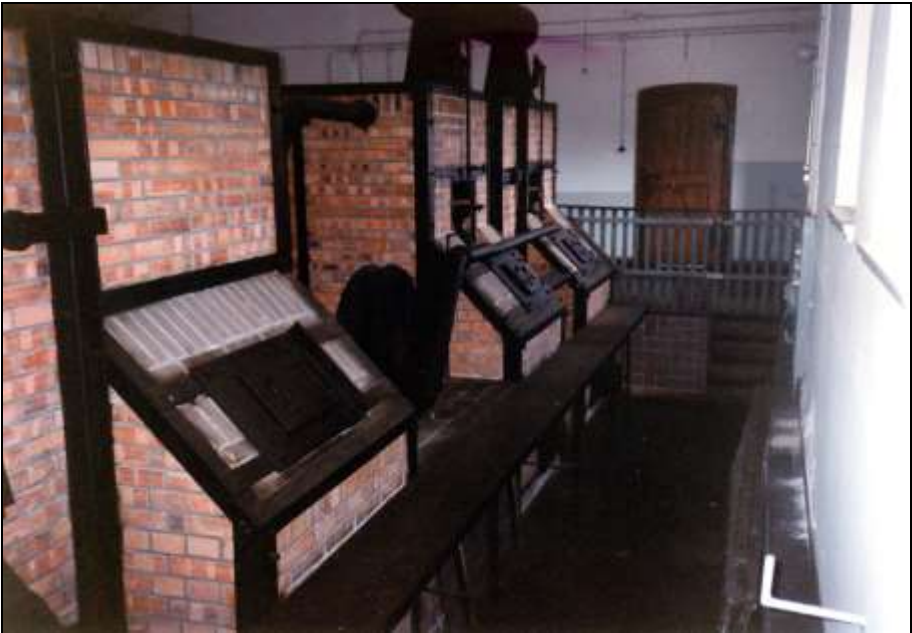
Foto 158: TOPF, Dreimuffel-Kremierungsöfen; rechte Rückansicht mit Generatorfüllschachtverschlüssen (oben) und Aschentüren in der Wartungsgrube (unten).
