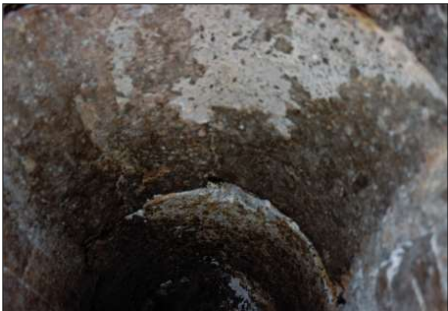
Foto 26: Rechte Muffel: Gewölbte Muffeldecke mit Austritt von einem der Rohre, die an ein Gebläse angeschlossen sind.
