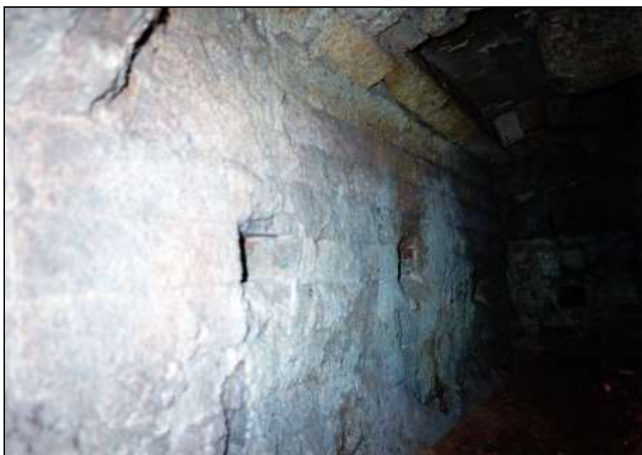
Foto 241; wie zuvor, Nahaufnahme der Verbrennungsluftzufuhrlöcher.
