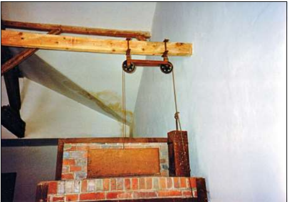
Foto 255: Vierter Ofen, Vorderansicht: Eisenverkleidung der Muffeltür-Absperrplatte aus Schamott; Drahtseil, Umlenkrollen und Gegengewicht zwecks Bedienung der Absperrplatte.
