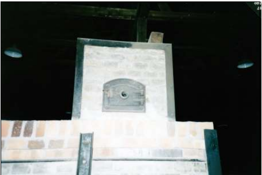
Foto 310: wie zuvor, Rauchkanalstruktur mit Reinigungstür.
