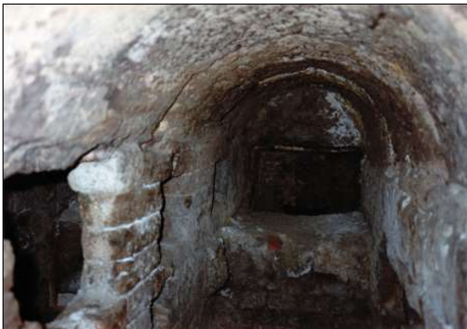
Foto 22: Rechte Muffel: links die Trennwand mit den drei Verbindungsöffnungen.
