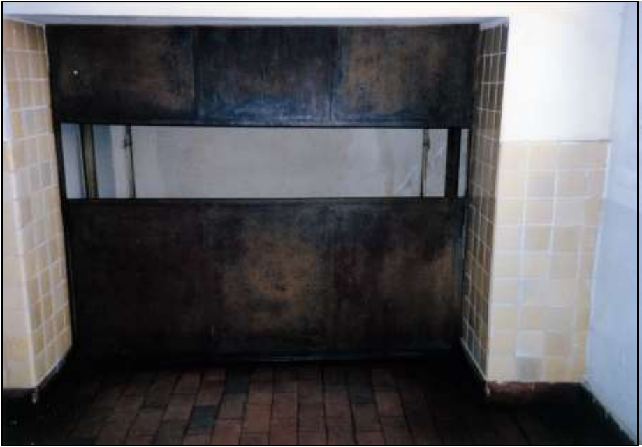
Foto 214: wie zuvor, Lastenaufzugstür in der Kremierungshalle, Erdgeschoss.
