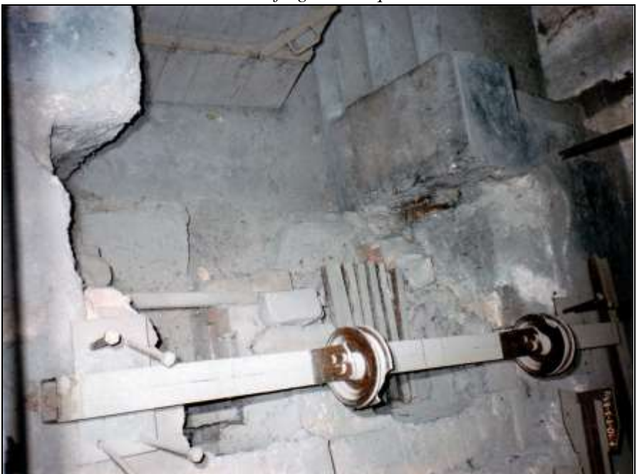
Foto 100: Trümmer des Fundaments von Ofen Nr. 3: Wartungsgrube und Generatorherd von oben betrachtet.
