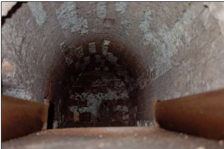
Foto 139: wie zuvor; rechte Muffel. Vordergrund: die Leichentrage des Einführwagens. Im Hintergrund ist die Öffnung des Ölbrenners in der Wand zu sehen.
