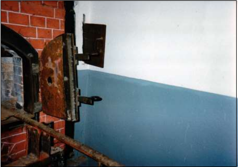
Foto 238: wie zuvor, rechte Seite; in der Wand der Kaminschieber.
