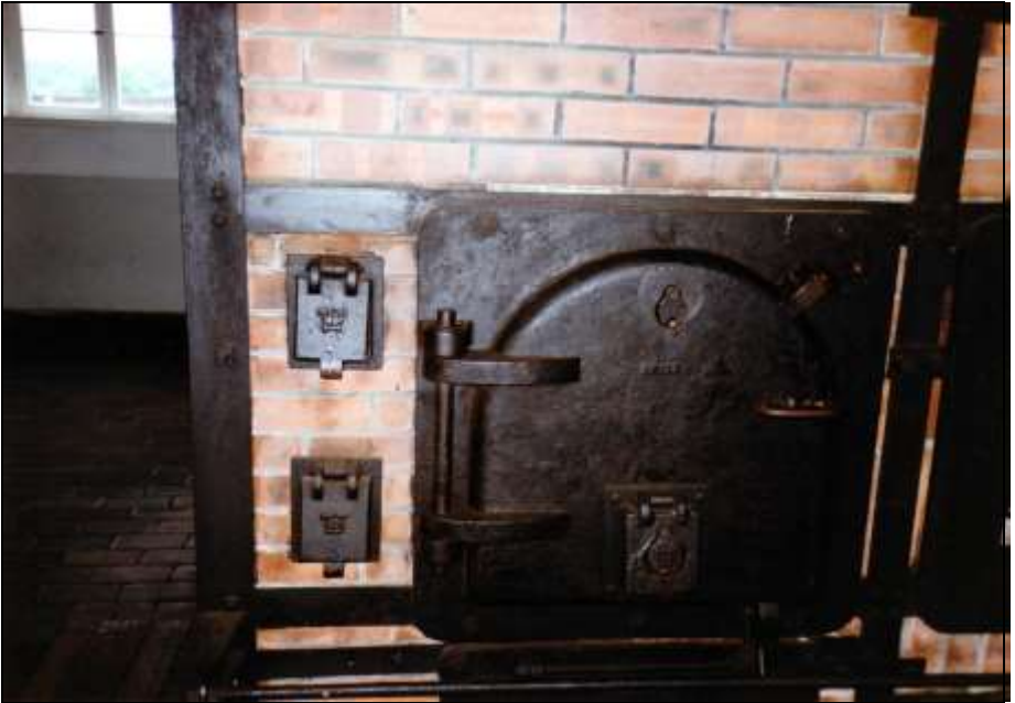
Foto 150: wie zuvor, linke Muffel. Links der großen Muffeltür: Klappen der Verbrennungsluftkanäle der Muffel (oben) und der Aschenkammer (unten).
