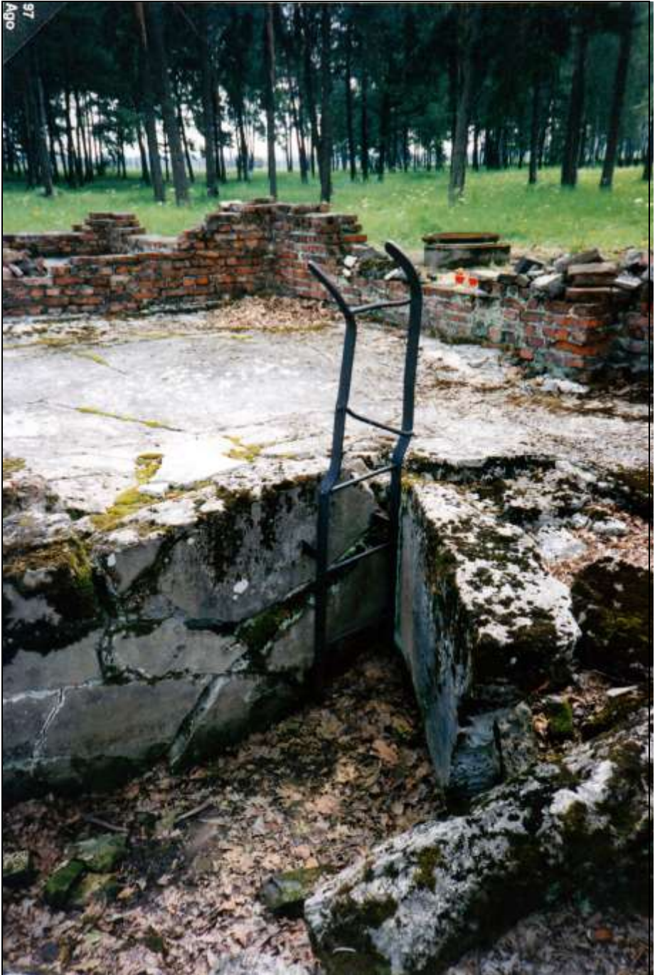
Foto 232: wie zuvor. Südliche Wartungsgrube mit Leiter.
