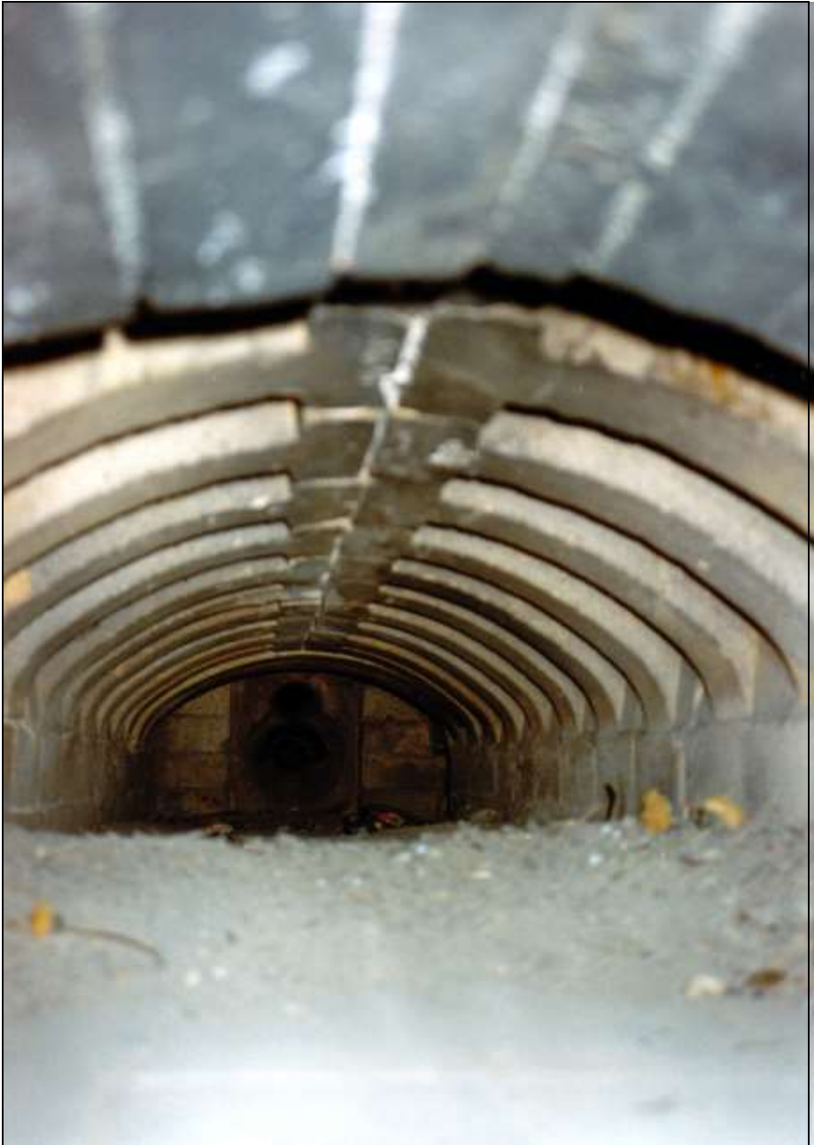
Foto 323: Aschenkammer; oben: die Unterseite des Schamottrosts der Muffel; Hintergrund: Düse des Hilfsbrenners.
