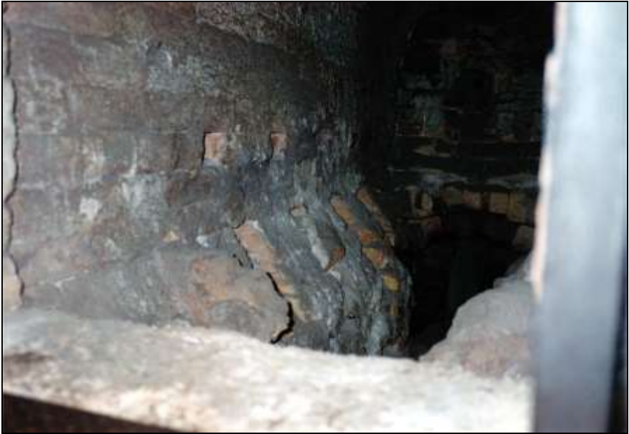
Foto 131: wie zuvor; in der linken Wand sind vier Öffnungen des Verbrennungsluftkanals sichtbar; darunter die Überreste der Muffelroststäbe und die abgeschrägte Wand der Aschenkammer; im Hintergrund unten ist die Öffnung zum Generator.
