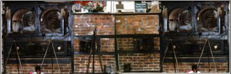
Dokument 241: Fotomontage von zwei gespiegelten Fotos des TOPF-Doppelmuffel-Kremierofens im Lager Gusen zwecks Illustration der Struktur des Topf-Achtmuffelofens.
