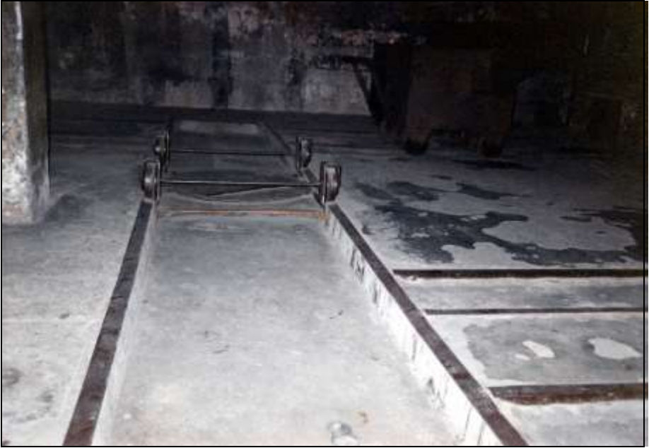
Foto 105: Längsschienen mit Drehscheibe.
