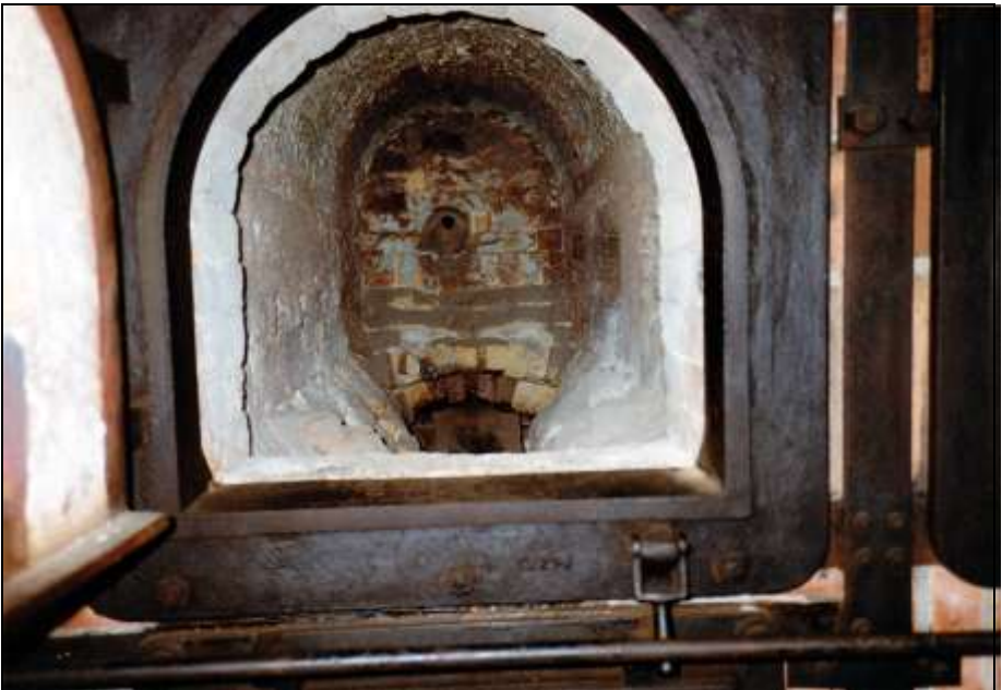
Foto 130: Ort wie zuvor; Inneres der linken Muffel des koks- und ölbefuearter TOPF-Dreimuffel-Kremierungssofens.
