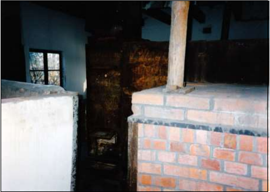
Foto 50: Linke Seite des Ofens; Hintergrund: offene Zugriffsklappe zum Lockfeuer am Kaminboden.
