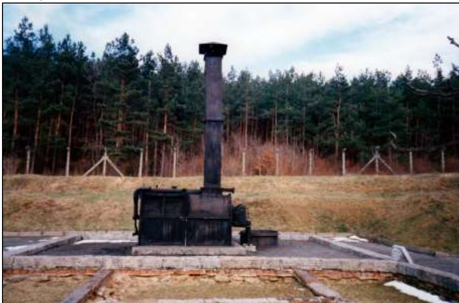
Foto 332: Ofen auf dem Fundament der vormaligen Kremierungshalle.
