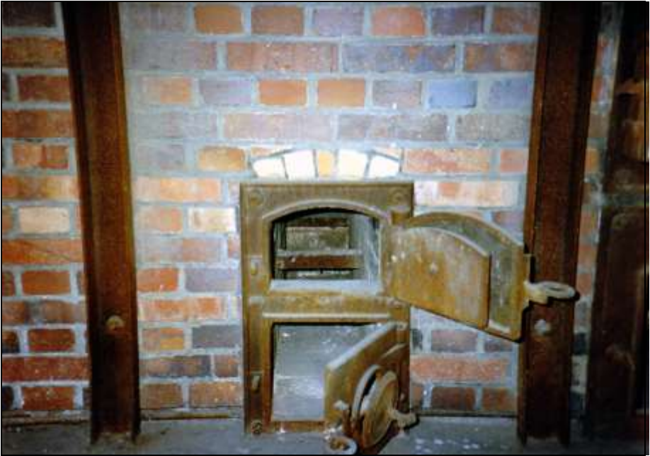
Foto 260: Erster Ofen, Bedienungstüren des Hilfsgenerators: Koksfülltür (oben) und Aschentür (unten).
