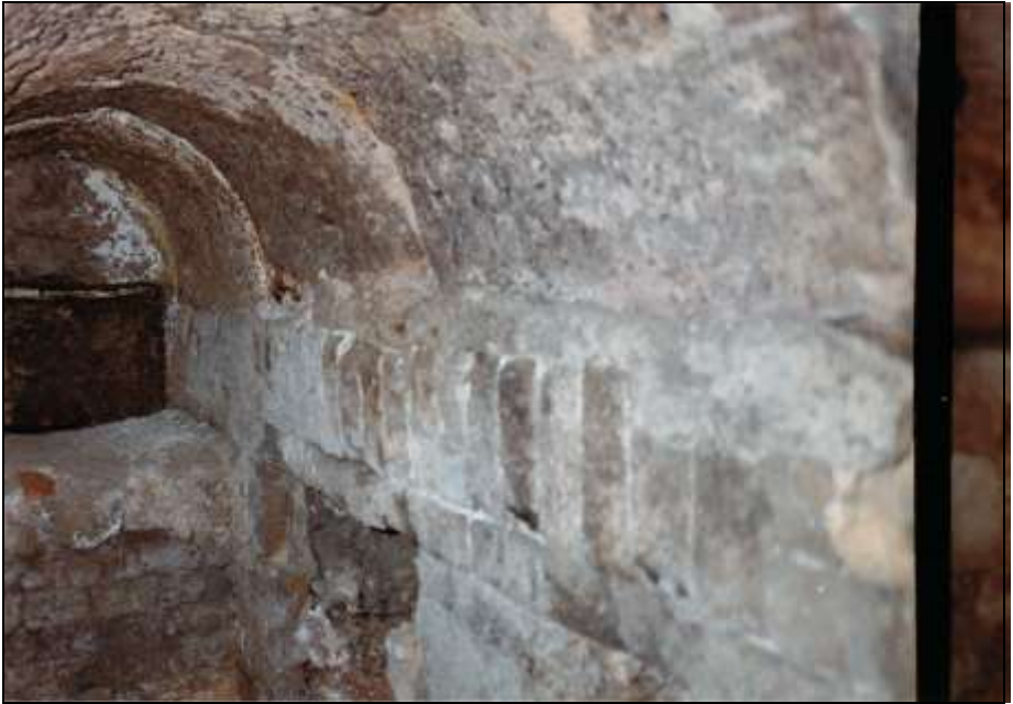
Foto 28: Rechte Muffel: Seitenwand der Muffel und des Aschenraums mit Öffnung, die ihn mit dem Generator verbindet.
