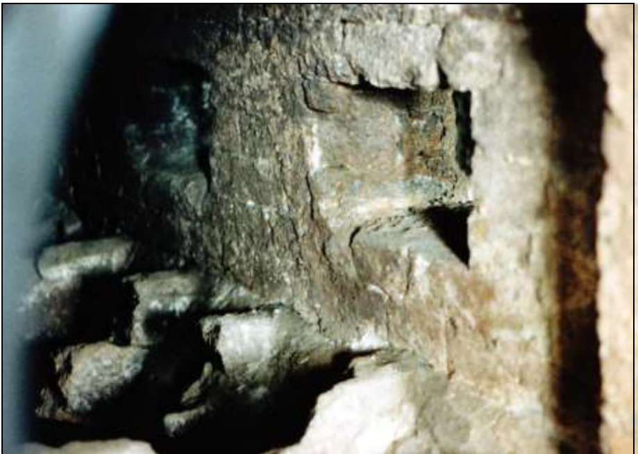
Foto 144: wie zuvor, mittlere Muffel, rechte Wand mit rechteckigen Öffnungen zur rechten Muffel.
