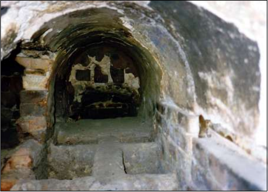
Foto 40: Das Innere der rechten Muffel mit Muffelrost.
