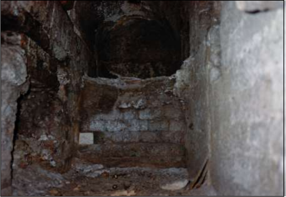
Foto 18: Linke Muffel: Aschenraum. Unten links ist die erste Öffnung zu sehen, die ihn mit dem Generator verbindet.
