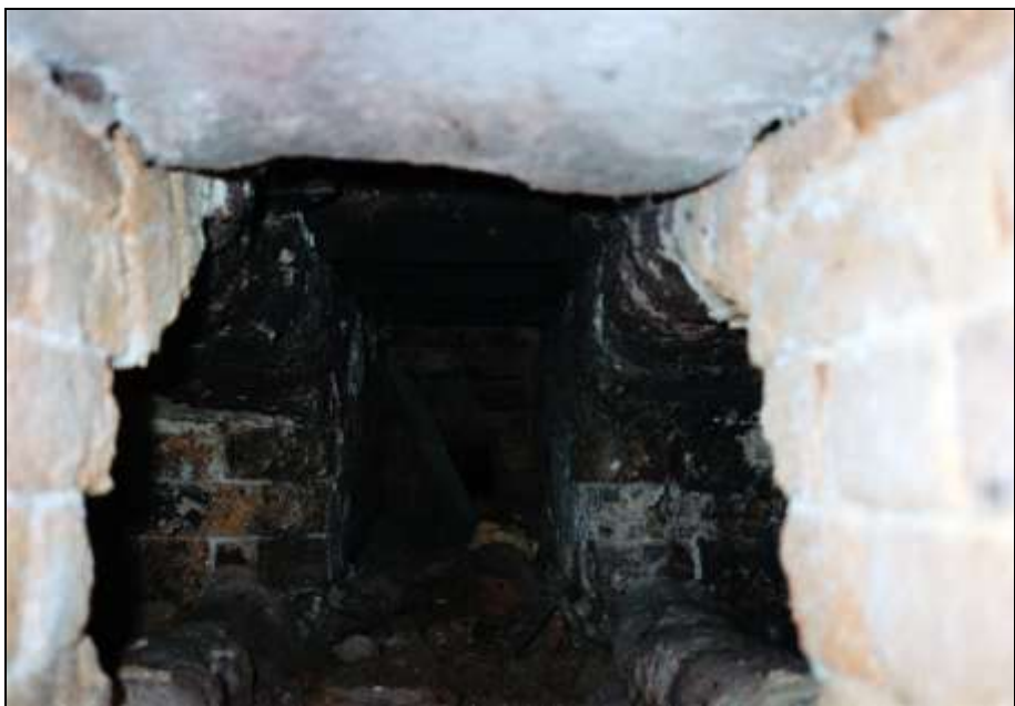
Foto 156: wie zuvor, Aschenkammer der mittleren Muffel mit den zwei seitlichen Öffnungen zum Fuchs und einem Verbrennungsluft-Zufuhrloch im Hintergrund.
