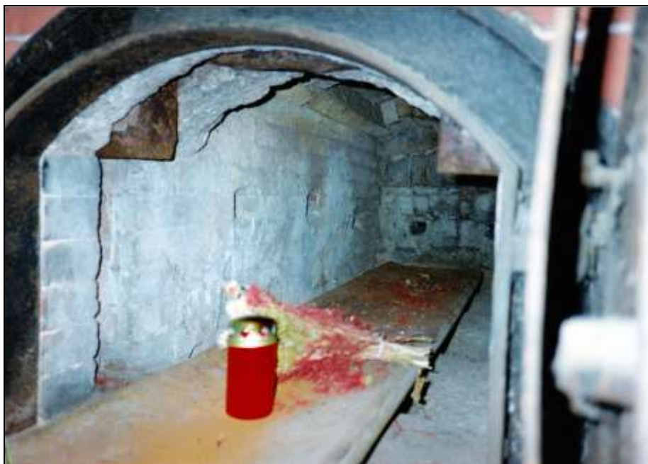
Foto 240: wie zuvor; linke Muffelwand mit Öffnungen für die Verbrennungsluftzufuhr.
