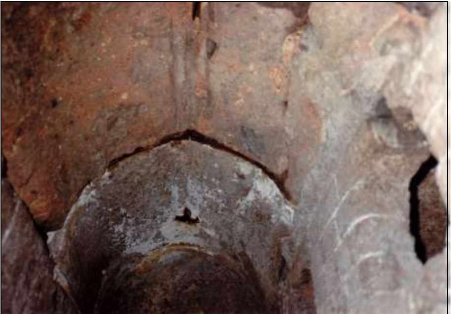
Foto 19: Linke Muffel: Gewölbte Muffeldecke mit Austritt von einem der Rohre, die an ein Gebläse angeschlossen sind.
