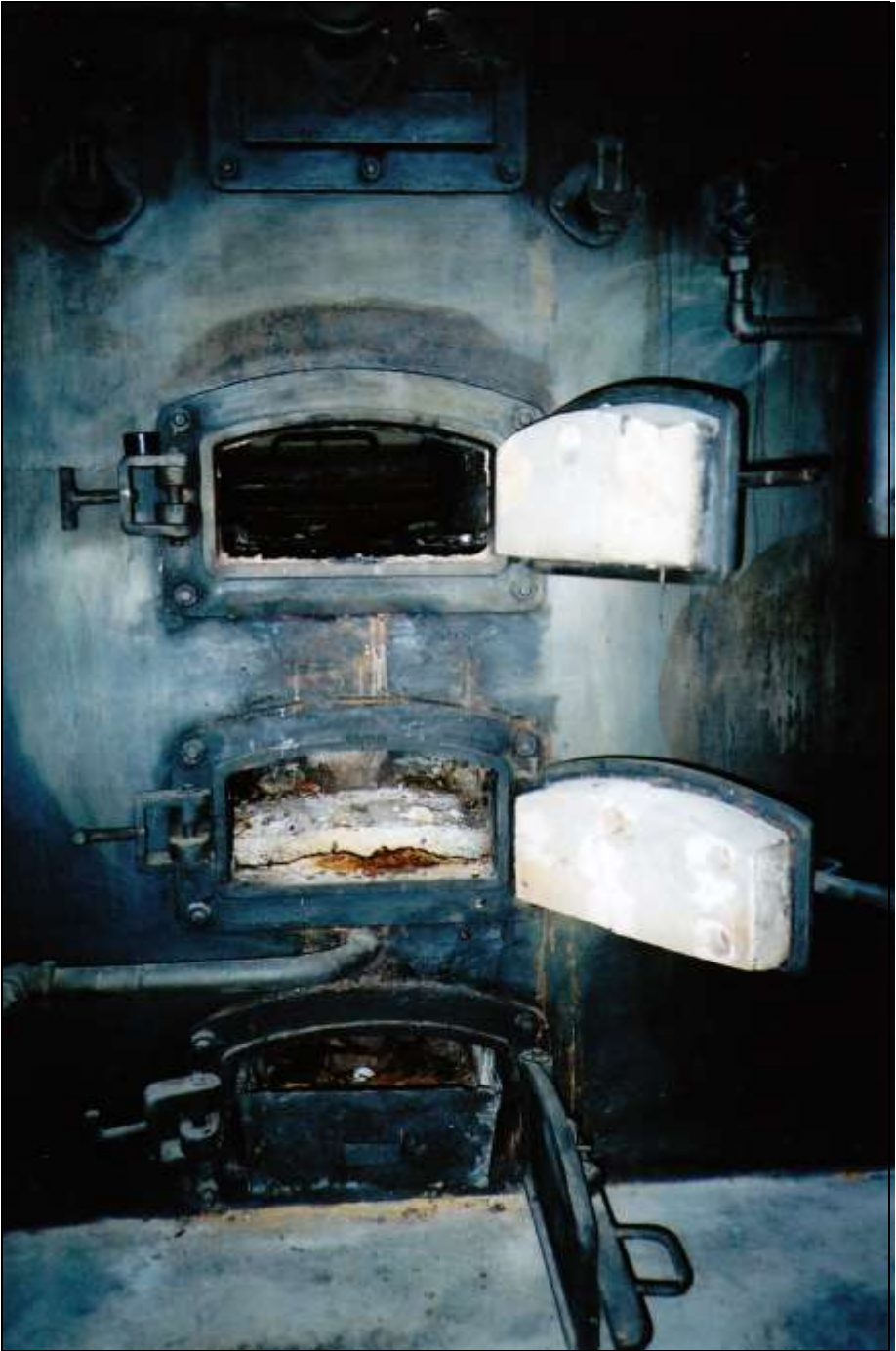
Foto 351: Linker Ofen des vorderen Paares, Rückansicht; drei Reinigungstüren: zur Muffel (oben), zur Nachbrennkammer (Mitte) und zur Aschenkammer mit dem Aschenbehälter (unten).
