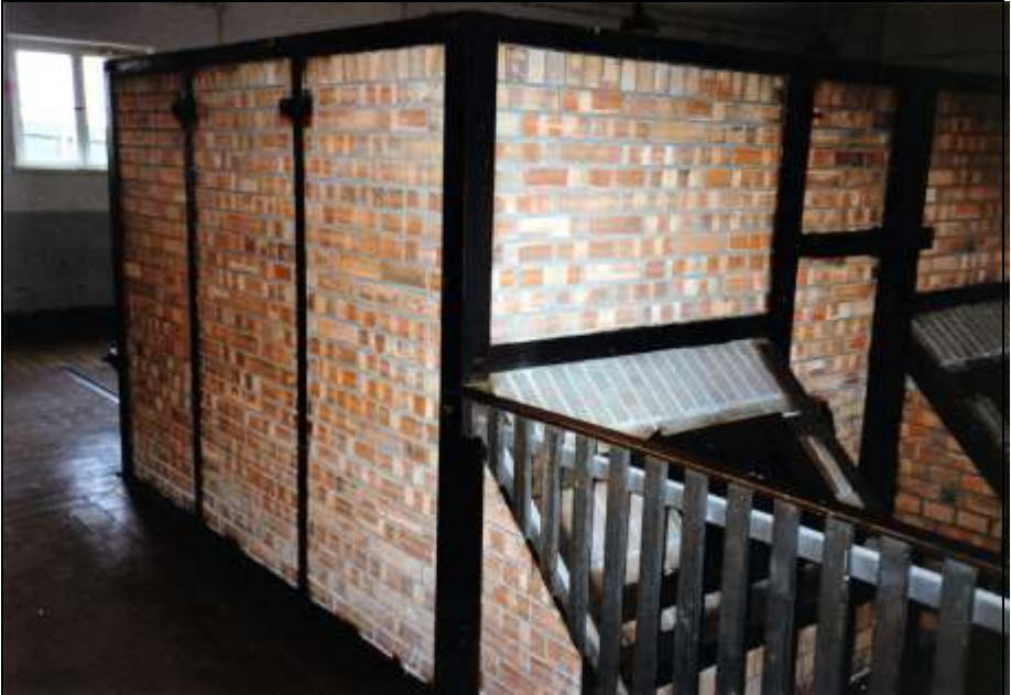
Foto 126: wie zuvor, linke Rückansicht mit Generatorfüllschachtverschluss.
