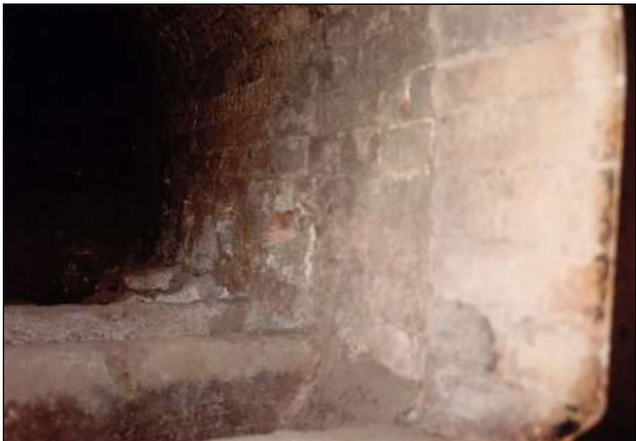
Foto 147: wie zuvor, rechte Muffel, quadratische Öffnungen für die Verbrennungsluftversorgung. Unten: der Muffelrost.
