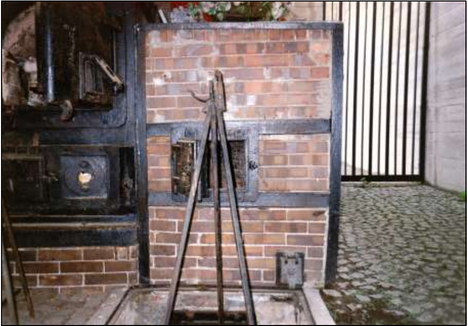
Foto 8: Des Ofens rechter Generator mit Koksfülltür und des Generators Primärluft-Zutrittsöffnung.
