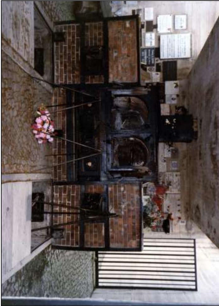
Foto 1: Ursprünglicher Ofenkörper aus beschichtetem Blech mit beidseitig angebrachten gemauerten Koksgasgeneratoren.
