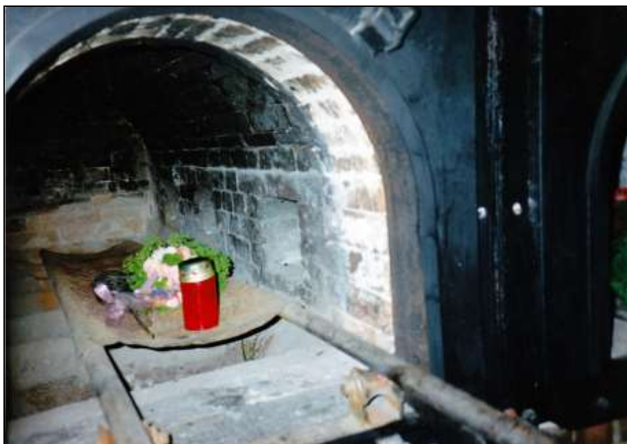
Foto 63: Linke Muffel; die drei Verbindungsöffnungen kann man rechts sehen.
