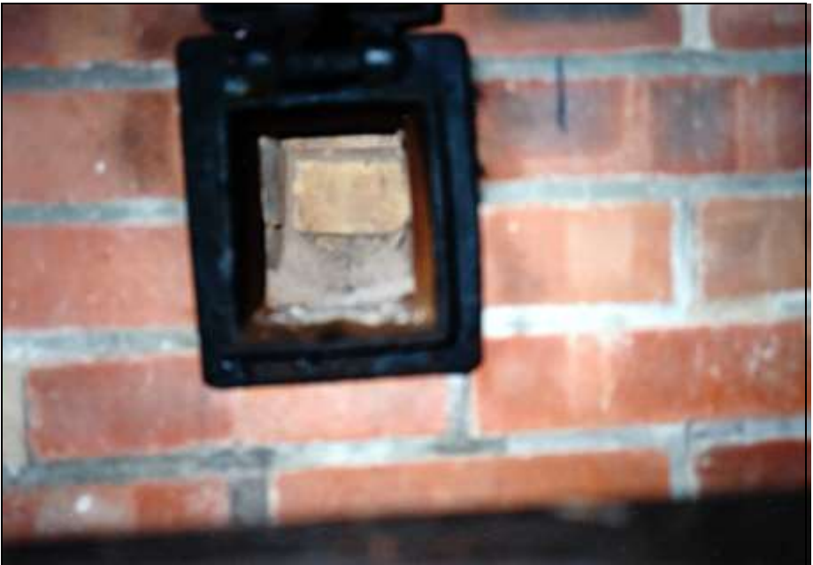
Foto 170: wie zuvor; Nahaufnahme des Verbrennungsluftkanals zur Muffel.
