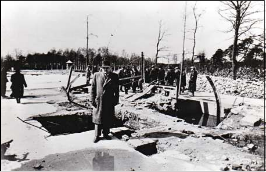
Foto 222: Trümmer von Krematorium V. Gusseiserner Rahmen des TOPF-Achtmuffelofens mit Wartungsgrube. Polnisches Foto von Mai 1945. APMO, Negativ Nr. 21334/141.
