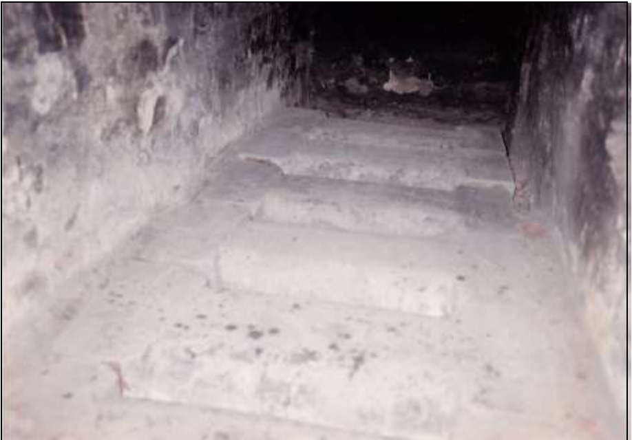
Foto 95: wie zuvor; Rost der rechten Muffel.
