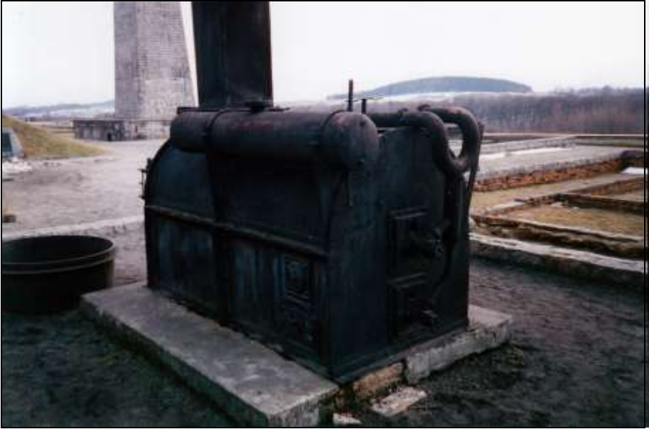
Foto 333a: Rückansicht. Links oben: Öltank; darunter: Verbrennungslufteinlass und Reinigungstür; rechts oben: Verbrennungsluftleitung; Rückseite: Haupt- (oben) und Hilfsbrenner (unten).
