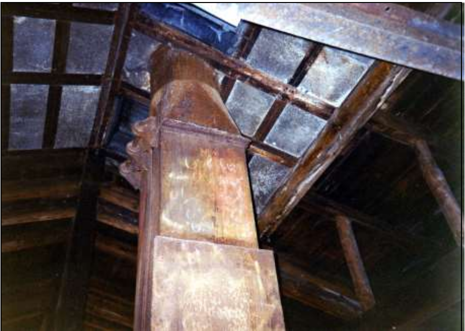
Foto 49: Oberteil des Kamins.
