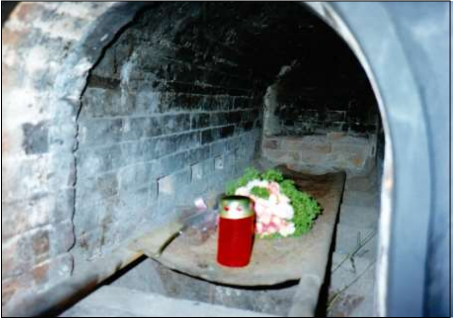
Foto 52 & 53: Linke Muffel. An der linken Muffelwand sind vier Zutrittslöcher für die Verbrennungsluft. Unter der Leichentrage sind die Roststäbe sichtbar.
