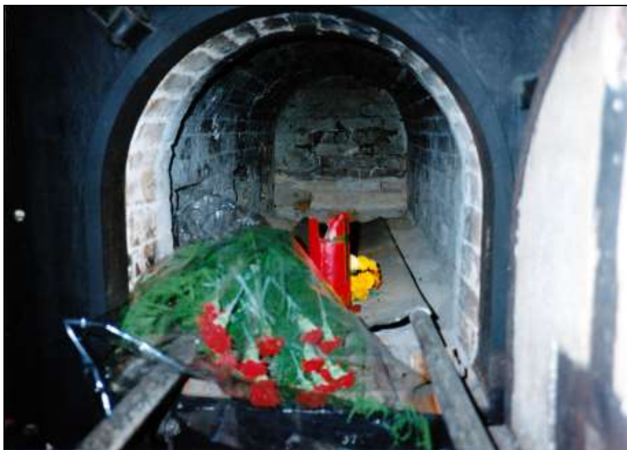
Foto 62: Rechte Muffel; die drei Verbindungsöffnungen sind links zu sehen.
