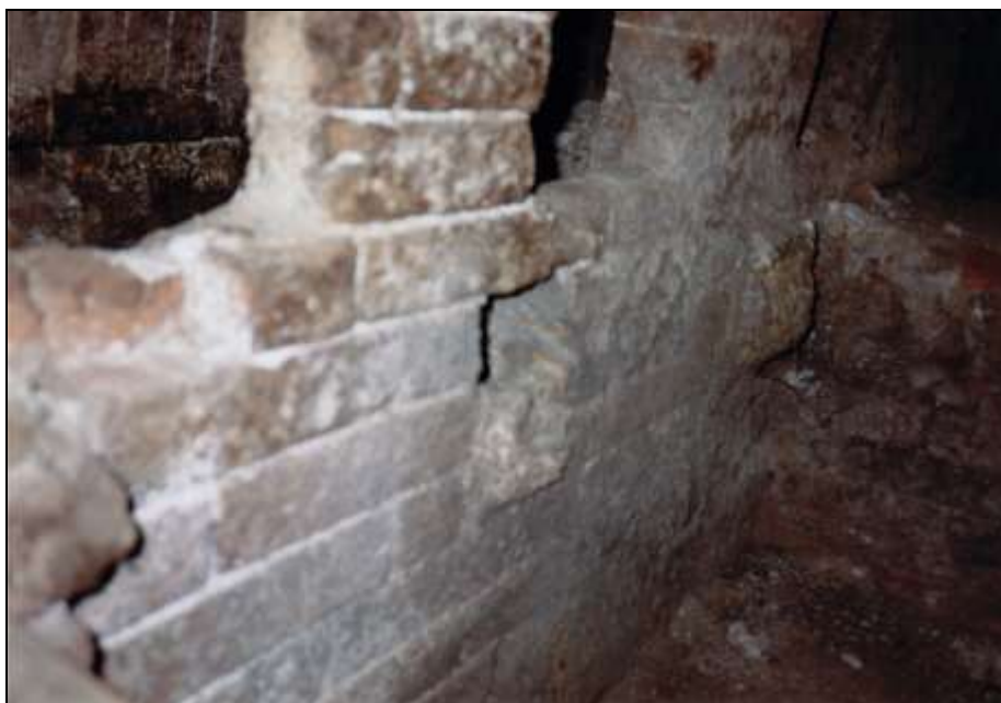
Foto 23: Rechte Muffel: Detail der Trennwand mit Verbindungsöffnungen.
