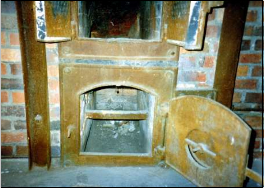
Foto 262: Aschentür des Hauptgenerators.
