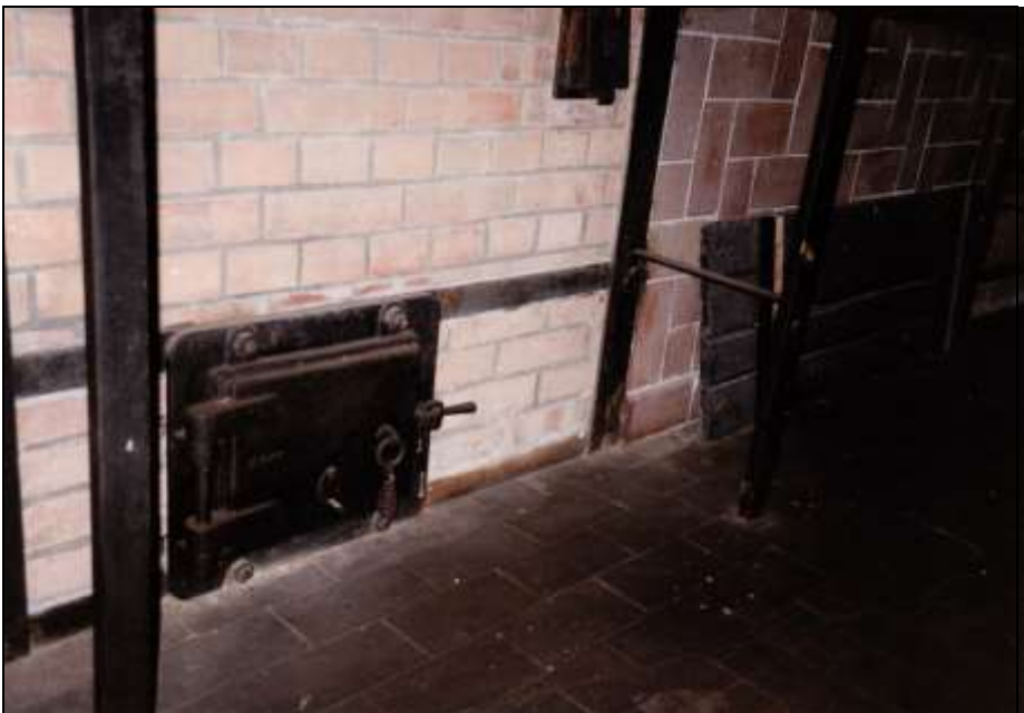
Foto 176: wie zuvor, linke Muffel: Aschentür des Generators (unten) und die Klappe seines Verbrennungsluftkanals (oben rechts).
