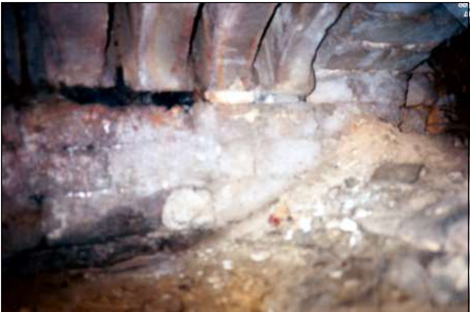
Foto 284: wie zuvor; rechte Wand der Muffel-Aschenkammer, von der Aschenkammer des Hilfsgenerators aus betrachtet; oben: gewölbte Muffelrostbalken.
