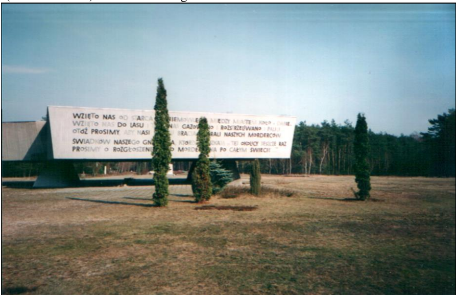
Dokument 22: Mahnmal am Eingang zum Lager Chelmno. (Foto von 1997). © Carlo Mattogno
