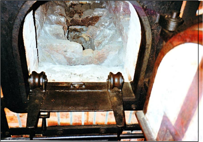
Dokument 40: Krematorium von Buchenwald. Koksbeheizter Topf-Dreimuffelofen. Rollensystem für Sargeinführungswagen in operationsbereiter Position. © Carlo Mattogno.
