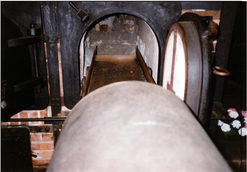
Dokument 41: Krematorium von Buchenwald. Koksbeheizter Topf-Dreimuffelofen. Leicheneinführungswagen mit Einführtrage, die in die Muffel eingeschoben wird. © Carlo Mattogno.
