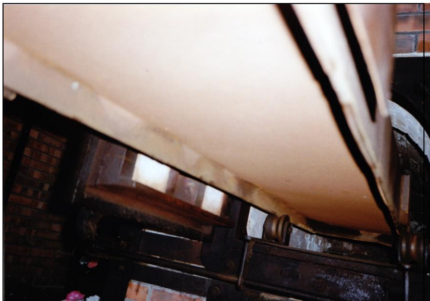
Dokument 42: Krematorium von Buchenwald. Koksbeheizter Topf-Dreimuffelofen. Zentrale Muffel. Leicheneinführwagen. Untere Seite. Ränder der sich auf Rollen bewegenden Einführtrage. © Carlo Mattogno.
