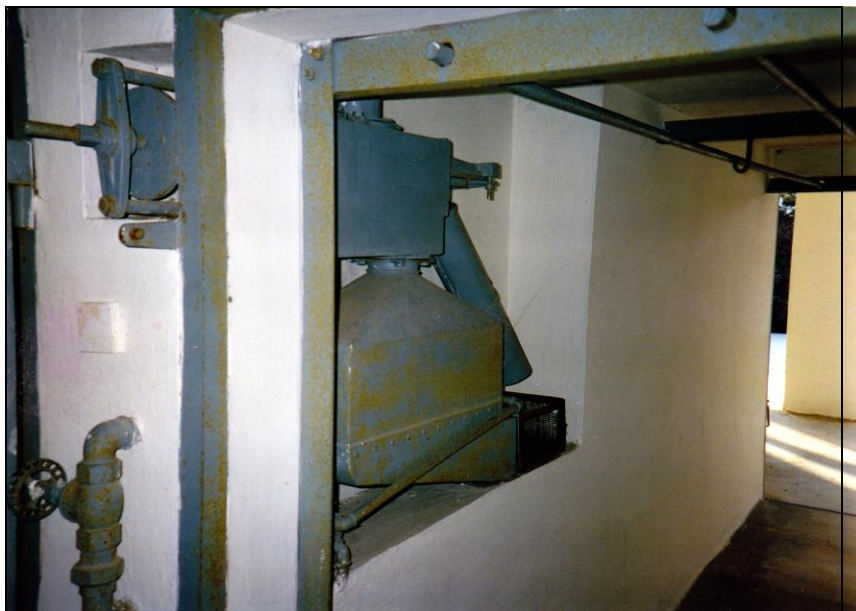
Dokument 13: Fotografie der stählernen Umluftanlage einer mit Blausäure (Zyklon B) betriebenen Degesch-Kreislauf-Entwesungskammer im KL Dachau. © Carlo Mattogno, 1990.
