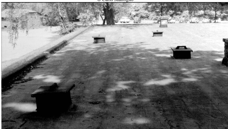
Dokument 23: Fotografie des Daches der Leichenhalle. Die vier von den Polen nach dem Krieg gebauten Schächte. © Carlo Mattogno
