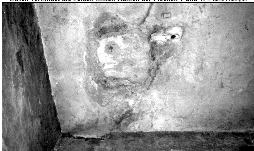
Dokument 19: Fotografie der Öffnung 1 in der Decke des Vorraumes, Teil der früheren Leichenhalle. © Carlo Mattogno
