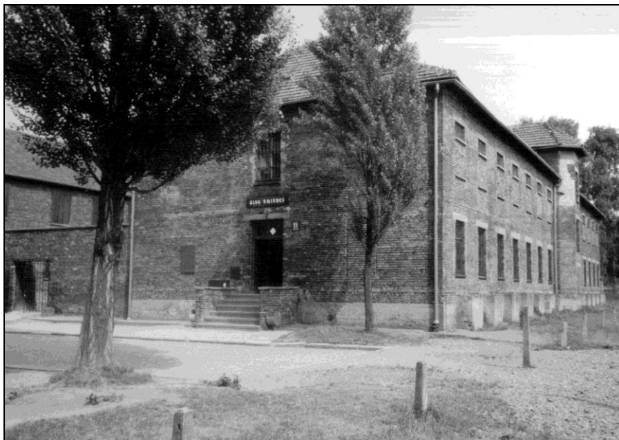
Foto 4: Block 11, außen, Nordwest- und Südwest-Mauern.
