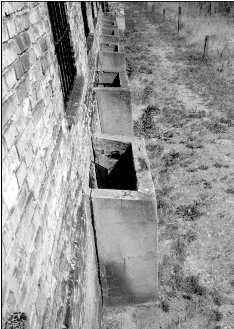
Foto 27: Block 11, außen, Südwest-Mauer, Betonmauern um die Fenster der Bunkerzellen.
