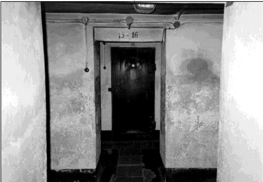
Foto 19: Block 11, innen, Bunker, rechte Seite, Tür zur Zelle Nr. 16.
