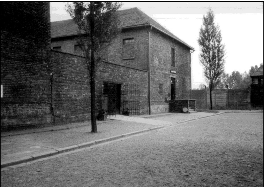
Foto 3: Block 11, außen, Nordwest-Mauer, Mauer und Tor zum Hof.
