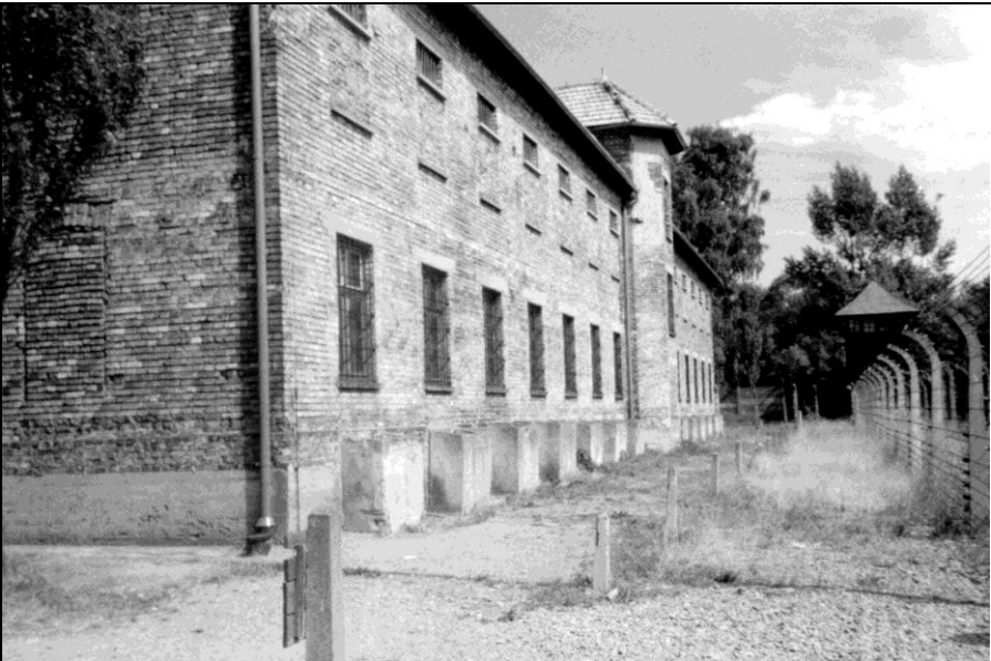
Foto 26: Block 11, außen, Südwest-Mauer, Betonmauern um die Fenster der Bunkerzellen.
