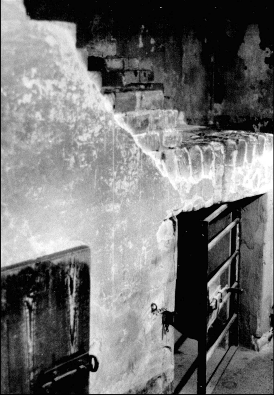
Foto 32: Block 11, innen, Bunker, rechte Seite, Stehzellen.
