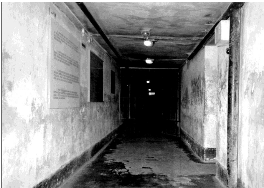
Foto 14: Block 11, innen, Bunker, rechte Seite, Mittelgang.
