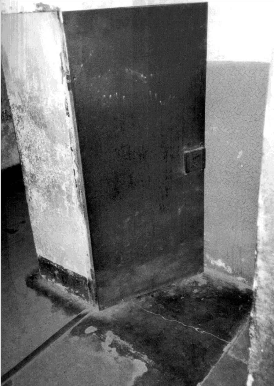
Foto 10: Block 11, innen, Stahltür zum Bunker, vom Treppenhaus gesehen.
