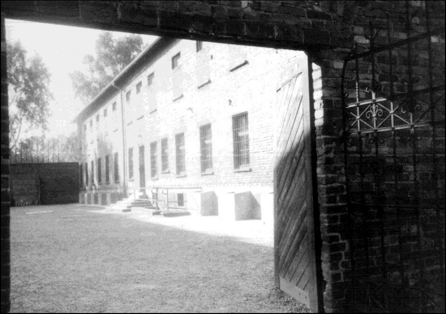
Foto 2: Block 11, außen, Nordost-Mauer, Hof.
