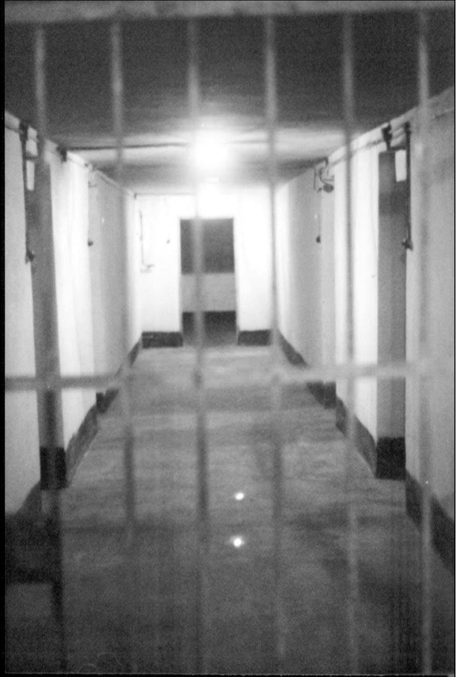
Foto 13: Block 11, innen, Bunker, linke Seite, Mittelgang.
