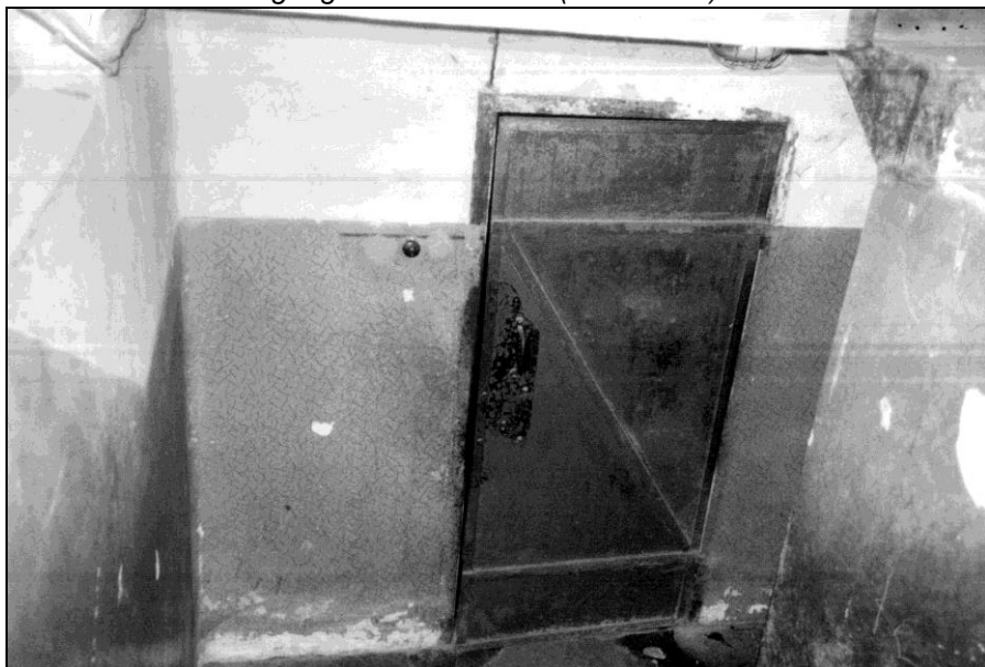
Foto 9: Block 11, innen, Stahltür zum Bunker, vom Treppenhaus aus betrachtet.
