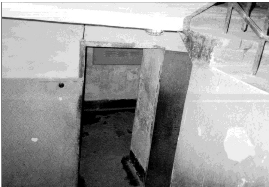
Foto 11: Block 11, innen, Stahltür zum Bunker, vom Treppenhaus aus gesehen.
