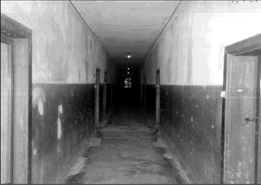
Foto 6: Block 11, innen, Erdgeschoss, Flur vom Eingang aus gesehen.
