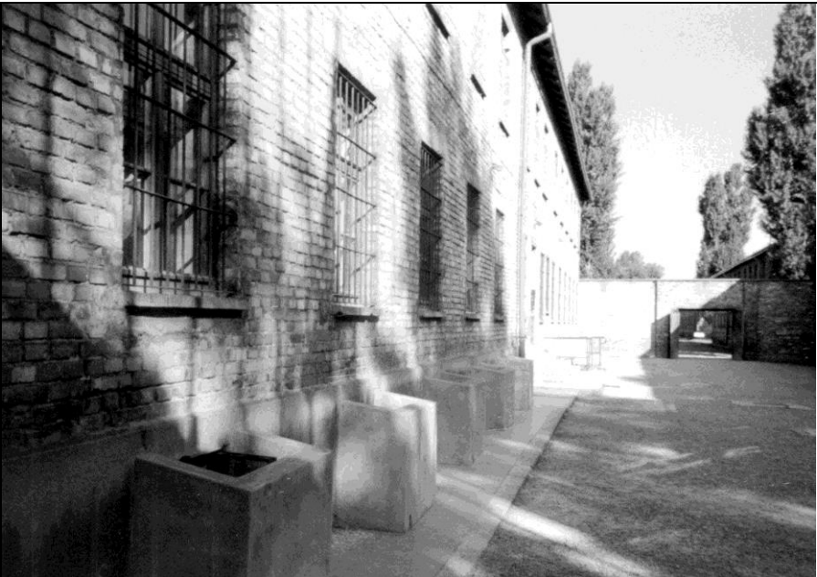
Foto 22: Block 11, außen, Nordost-Mauer, Betonmauern um die Fenster zu den Bunkerzellen.
