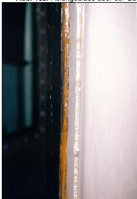
Abb. 104: Nahaufnahme der Gummidichtung am Rande der Gaskammertür, bei Benutzung zusätzlich mit Vaseline bestrichen.
