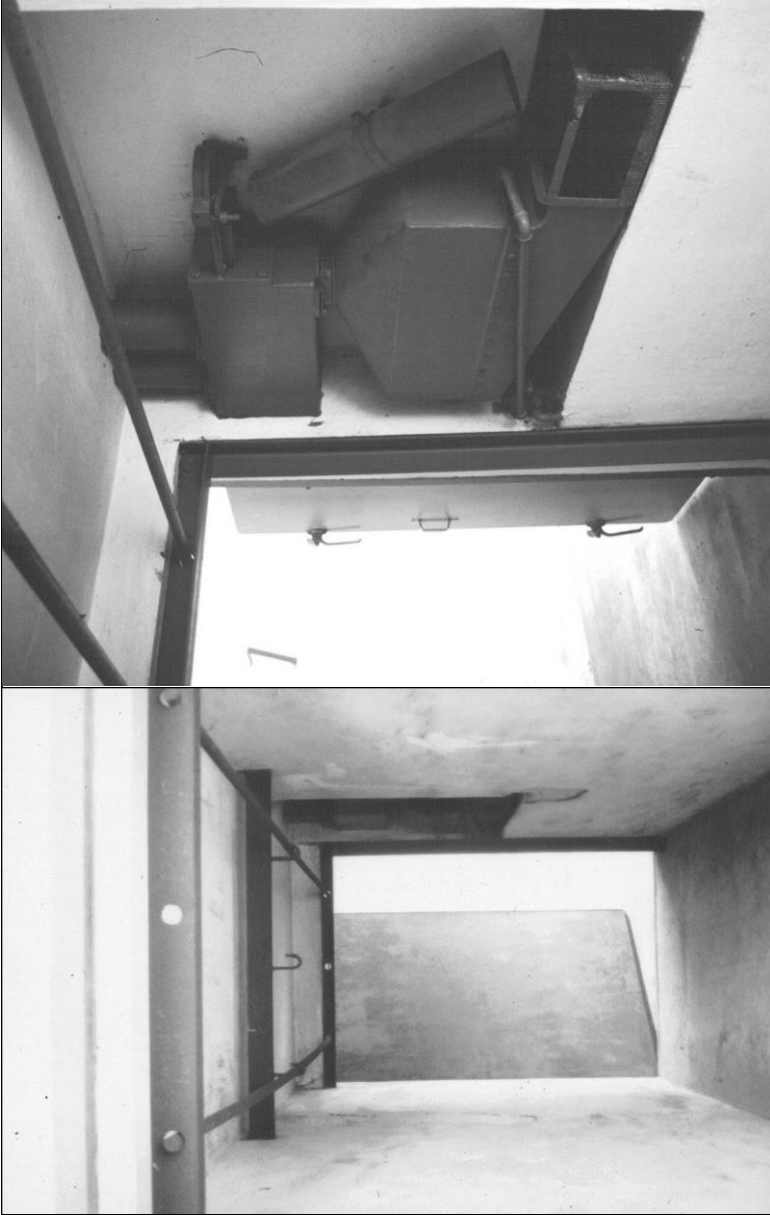
Abb. 71 & 72: Inneres einer Entwesungskammer in Dachau; rechts: DEGESCH Kreislaufanlage; links: Blick durch die Kammer. 4
