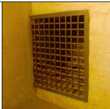
Abb. 63: Lufteinlass im Innern der angeblichen Gaskammern des Lagers Dachau.
