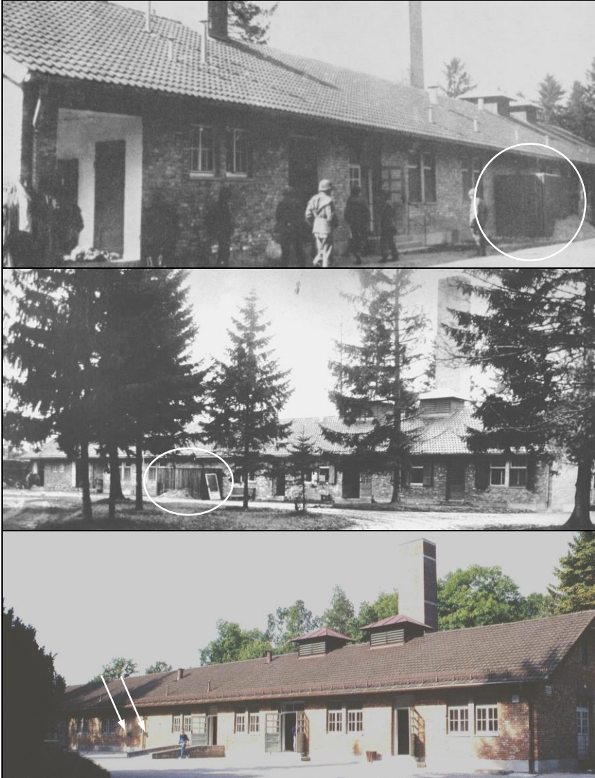
Abb. 67-69: Krematoriumsgebäude in Dachau; oben und Mitte: nach der Befreiung; unten: anno 1998. Man bemerke die Unterschiede: a) heute erlaubt eine Rampe den Zutritt auch für Personen in Rollstühlen; b) ein Schuppen (eingekreist) wurde entfernt; zwei Öffnungen (Pfeile, unten) sind nun an dieser Stelle sichtbar, die angeblich zum Einfüllen von Zyklon B in den Dushraum dienten – die behauptete Gaskammer. 2
