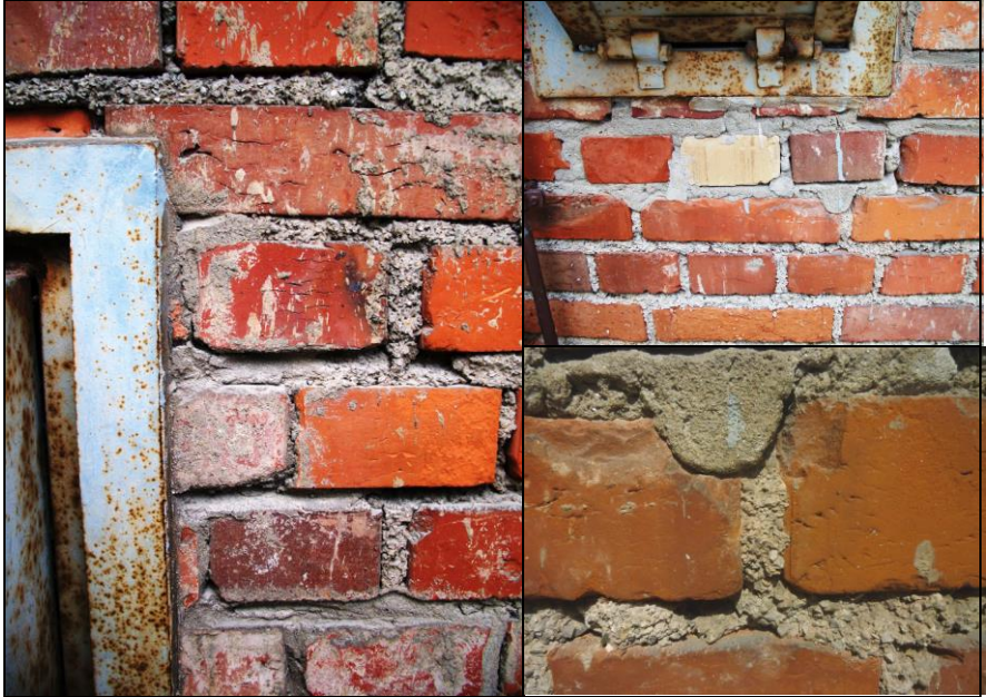
Abb. 50a (links), b, c (rechts): Außenansicht eines der angeblichen "Zyklon-B-Einwurflocher" der behaupteten Gaskammer in Dachau. Der für die umliegenden Ziegelsteine verwendete andersartige Mörtel beweist, dass die Löcher für diese Schächte nachträglich durchgebrochen wurden.
