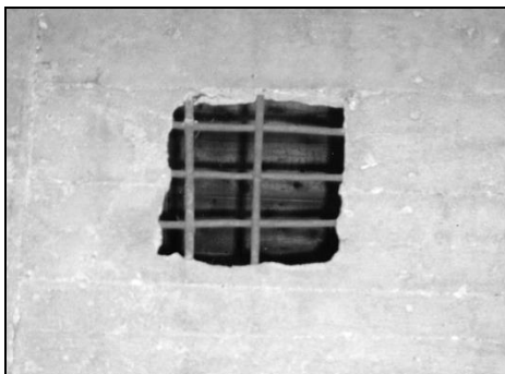
Abb. 33: Neues Krematorium im Lager Majdanek, angebliche Gaskammer, Öffnung in der Decke.
