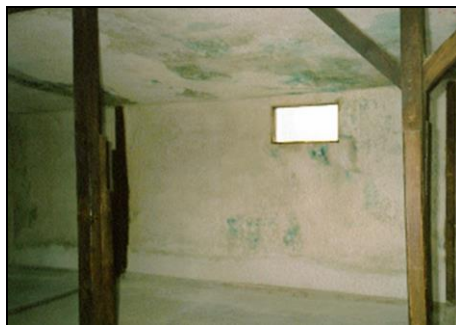
Abbildung 31: Fenster im Raum IV von Gebäude Nr. 41 (angebliche Menschengaskammer, tatsächlich aber einer Entlausungskammer), Lager Majdanek.
