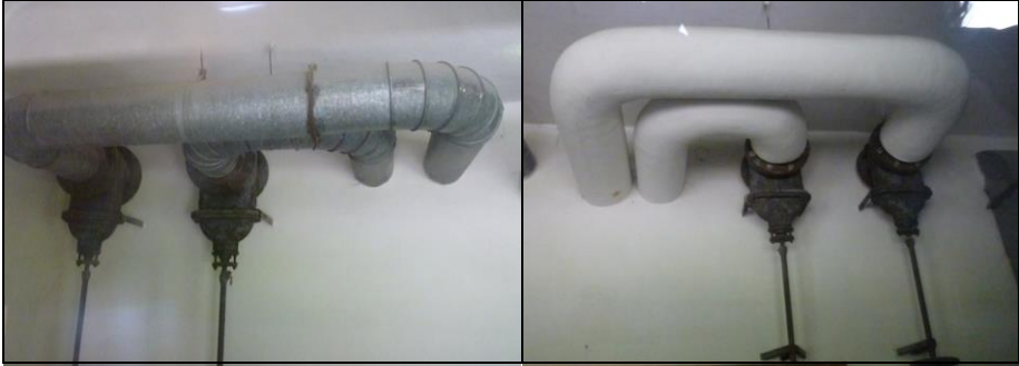
Abb. 54f.: Dicke Rohrleitungen im Raum hinter und über der Dachauer "Gaskammer."
