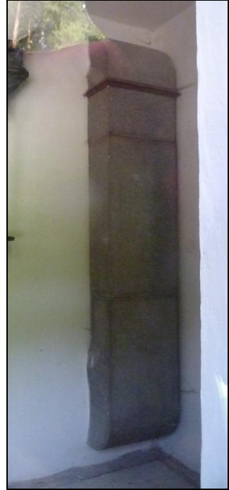
Abb. 57: Warmluftzufuhrschacht hinter der Dachauer "Gaskammer".
