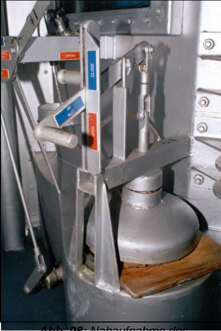
Abb. 98: Nahaufnahme der Frischluftzufuhr der Gaskammer.
