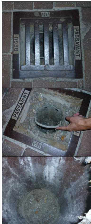
Abb. 61a-c: Oben: Einer der sechs Abwassergullys in der angeblichen Gaskammer des KL Dachau. Mitte: Deckel entfernt, Henkel des Siebes angehoben. Unten: Sieb entfernt. Am Boden des Topfes, auf dem Bild oben, leicht links versetzt, befindet sich das große Abflussloch.
