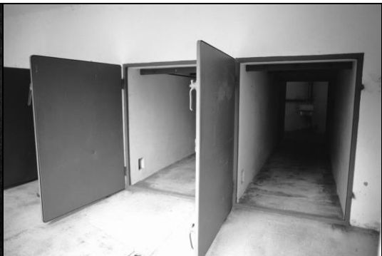
Abb. 27: Türen professioneller Entlausungskammern (DEGESCH Kreislaufanlage) im Lager Dachau.
