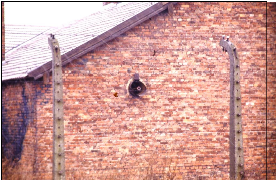
Abb. 25: Eine der zwei Lüftungsöffnungen des Entwesungstraktes von Bauwerk BW5b, heute ohne Gebläse. Die andere Öffnung befindet sich in derselben Wand etwas zur Linken. In der Öffnung ist das Ende einer Wasserleitung sichtbar, die dort nach dem Krieg eingebaut wurde.
