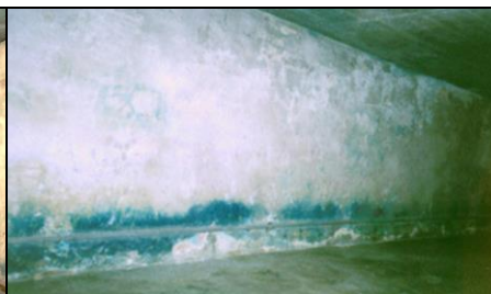
Abbildung 41: Zyklon-B-Entwesungsanlage, Kammer III (Ostwand), der Baracke 41 im KL Majdanek. (© C. Mattogno 224 )
