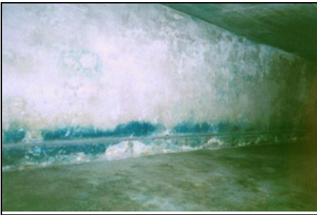
Abb. 89: Zyklon-B-Entwesungsanlage, Kammer III (Ostwand), der Baracke 41 im KL Majdanek. (© C. Mattogno)
