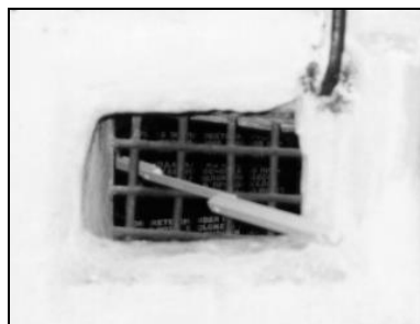
Abb. 148: Vergitterter Durchbruch in der Wand von Raum I der Entwesungsanlage bei Baracke 41, KL Majdanek (vgl. Planausschnitt Abb. 145)
