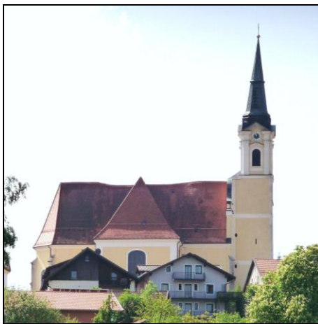
Abb. 84: Im Jahre 1972 wurde die katholische Kirche in Untergriesbach mit Zyklon B begast. Anschließend verfärbte sich der gesamte Verputz fleckig blau (Konrad Lackerbeck; Wikipedia commons).
