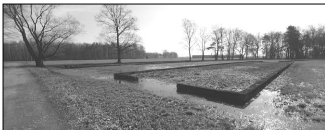
Abb. 66: Nach dem Kriege errichtete symbolische Fundamente der zwei Baracken westlich der Zentralsauna. Man beachte den hohen Grundwasserstand.
