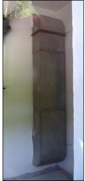
Abb. 26: Warmluftzufuhrschacht hinter der Dachauer Gaskammer.
