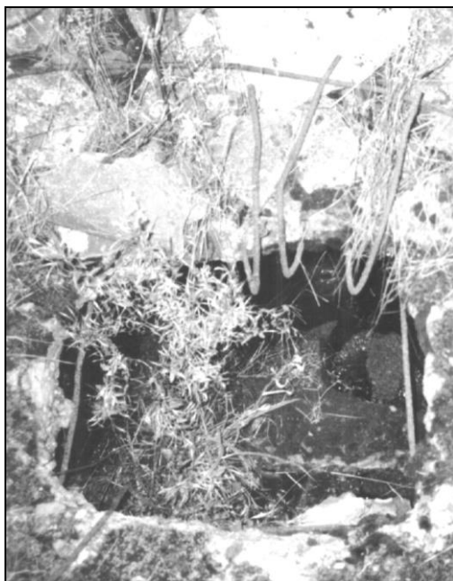
Abb. 98: Angebliches Zyklon-B-Einwurfloch in der Decke des Leichenkellers 1 (“Gaskammer”) von Krematorium II. Es ist deutlich sichtbar, dass es nicht von den Bewehrungseisen des Stahlbetons befreit wurde. Diese wurden einfach nach hinten umgebogen. © Carlo Mattogno
