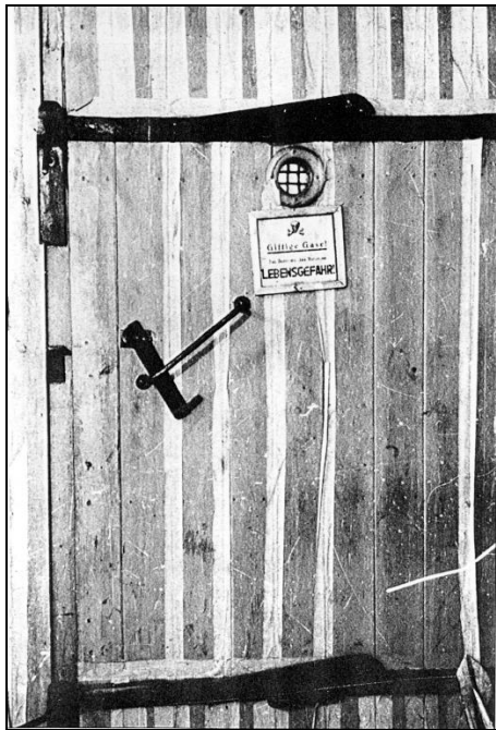
Abb. 124: Provisorisch gasdicht gemachte Holztür einer Entwesungskammer in Auschwitz mit Guckloch und Metallgitter davor. So sollen auch die gasdichten Türen für die Menschen-“Gaskammern” ausgesehen haben. Man beachte den äußerst labilen Verschluss.
