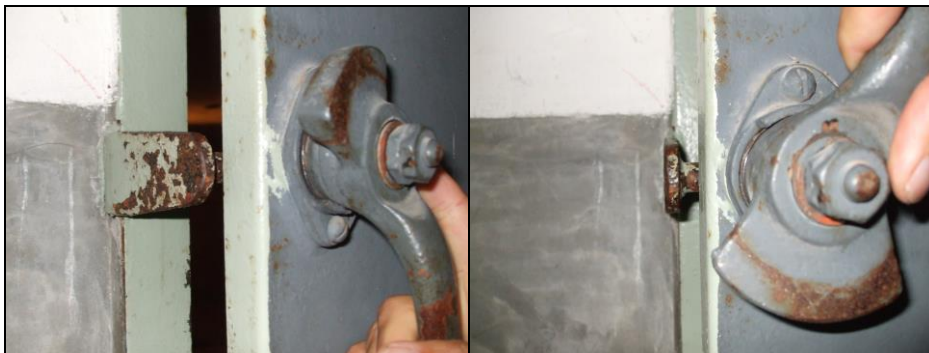
Abb. 28a & b: Heute können die Türen zur angeblichen Gaskammer in Dachau nicht geschlossen werden: der fehlende Schließmechanismus und an den Rahmen geschweißte Stahlstifte verhindern dies.
