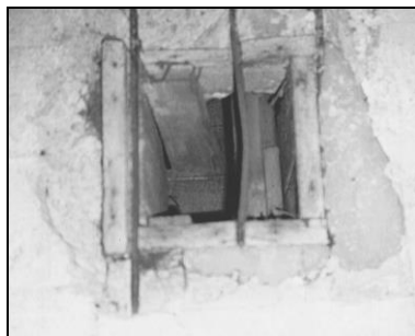
Abb. 150: Entlausungsanlage bei Baracke 41, Raum I, Öffnung in der Decke. (© C. Mattogno.)
