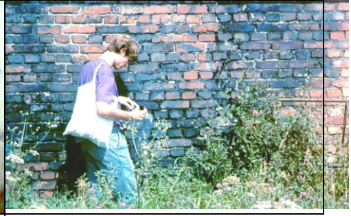
Abb. 88: Außenmauer Südwest des Zyklon-B-Entwesungstraktes des Bauwerkes BW 5b im KL Auschwitz-Birkenau.
