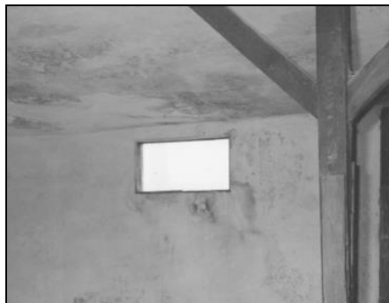
Abb. 146: Fenster an der Ostwand der Kammer IV, Baracke 41, (Entlausungskammer), KL Majdanek (vgl. Planausschnitt Abb. 145).
