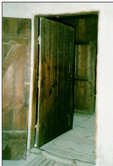
Fotografie XVII: Baracke 41, Gaskammer, Nordtür. Der innere Teil der Türe weist die typischen Flecken auf, die man auch auf der Außenwand der Südtüre (Fotografie XVIa) findet; am Türrahmen fehlen Haken für die Verschlusshebel, im Gegensatz zum Türgestell der Südtür (Fotografie XVI.) (© C. Mattogno.)
