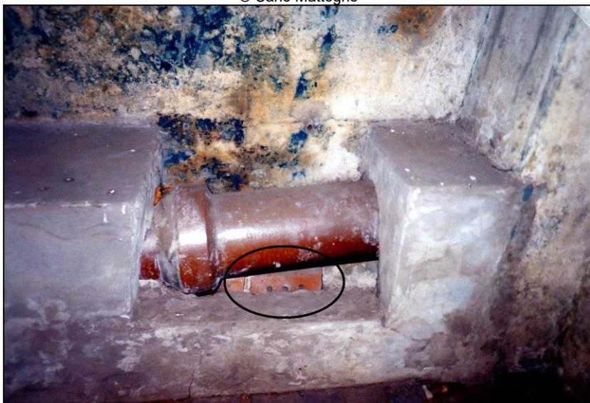
**Foto 8:** Entlausungskammer in Stutthof, Inneres, Westwand; gusseisernes Verbindungsrohr zum außerhalb der Gaskammer angebrachten Ofen, der zum Erhitzen der Luft diente. Ursprünglich war das Rohr von einem Mauerwerk umgeben, das dem auf dem Foto erkennbaren entspricht, jedoch aus durchlöchernten Backsteinen bestand. Einer dieser Ziegel ist noch heute unten hinter dem Rohr sichtbar (Kreis). © Carlo Mattogno
