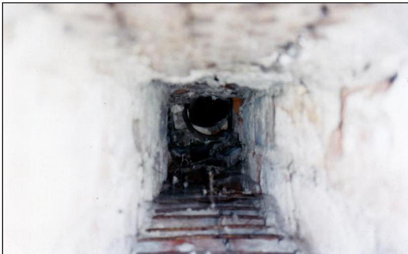
**Foto 7:** Entlausungskammer in Stutthof, Südseite. Ofen zum Erhitzen der Luft in der Gaskammer. Inneres der Brennkammer. Unten sieht man den Planrost, oben die runde Öffnung der Verbindung mit dem in der Entlausungskammer angebrachten gusseisernen Rohr.
