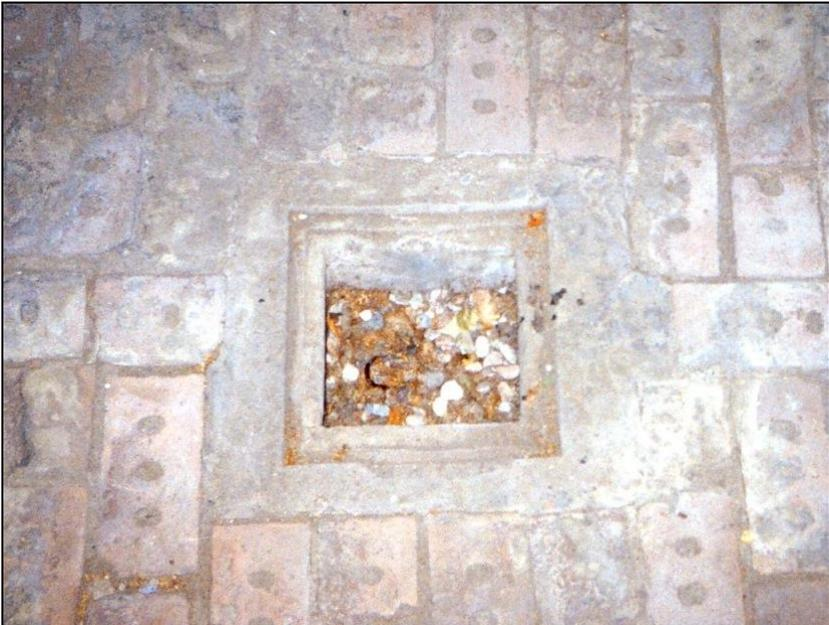
**Foto 13:** Entlausungskammer in Stutthof, Inneres. Entwässerungsschacht in der Mitte des Ziegelbodens unter der Zyklon-Einwurfluke.
