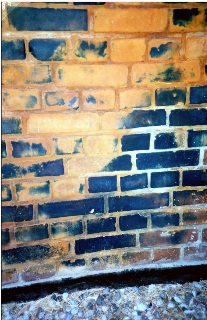
**Foto 16:** Entlausungskammer in Stutthof, Ostseite, außen. Auf den Ziegeln sieht man die typische Blaufärbung durch Eisenzyanide. © Carlo Mattogno
