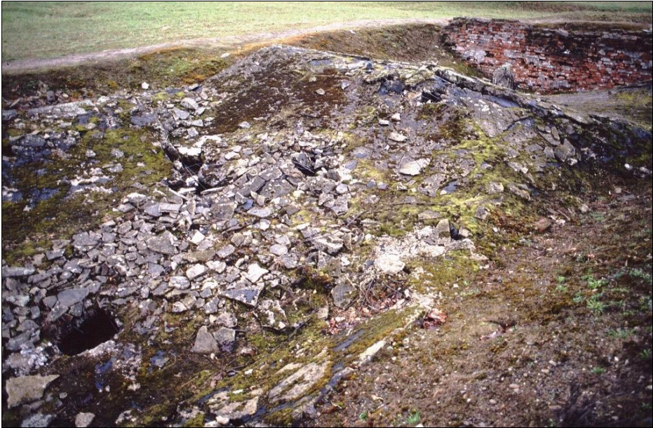
Abbildung 64: Leichenkeller 1 von Krematorium II in Birkenau, kollabiertes Dach, einigermaßen erhaltener hinterer Teil. Links: quadratisches Loch, nach der Zerstörung des Dachs hindurchgemeißelt, die Bewehrungseisen nur zurückgebogen (siehe Abb. 86, S. 142). (Februar 1997)
