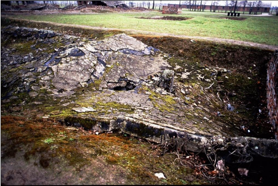
Abbildung 66: Leichenkeller 1 von Krematorium II in Birkenau, kollabiertes Dach, einigermaßen erhaltener, noch zugänglicher hinterer Teil. Mitte: Die letzte der sieben Betonsäulen ragt aus dem Dach hervor. Etwa einen Meter links davon: ein durch das Dach gemeißeltes Loch, um Zugang zum Bereich darunter zu erhalten (siehe Abb. 84, S. 140). (Februar 1997)
