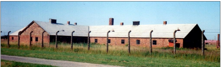
Abbildung 39: Bauwerk 5a, Birkenau, Juli 1992 (© C. Mattogno).
