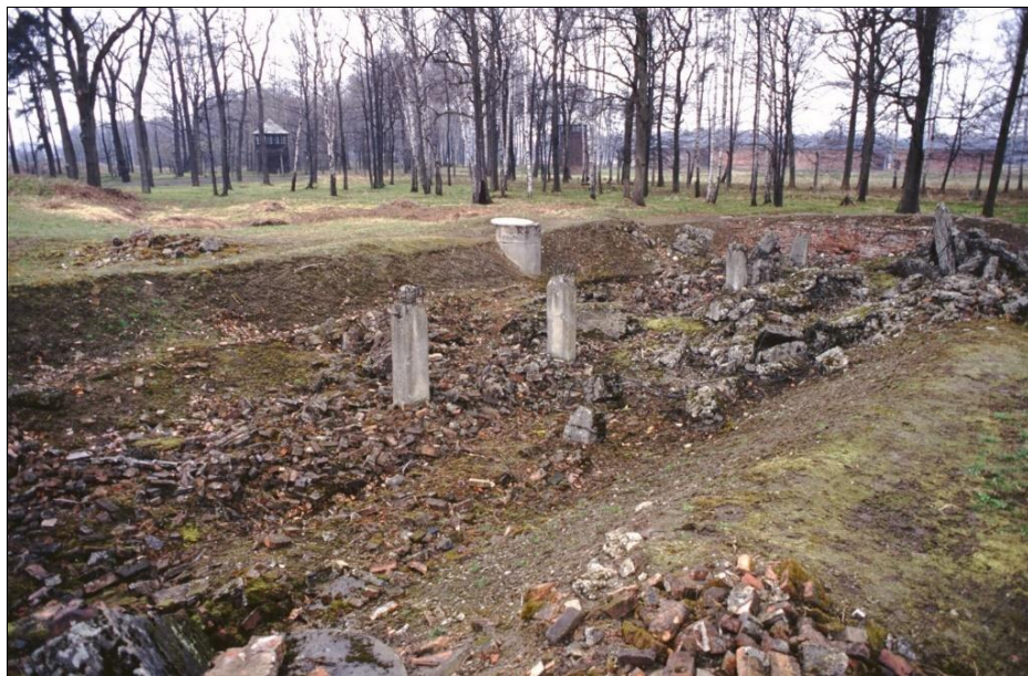
Abbildung 70: Leichenkeller 1 des Krematoriums III mit einem völlig zerstörtem Dach (Februar 1997).
