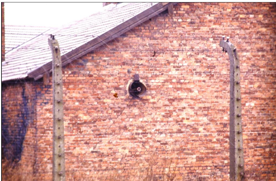
Abbildung 42: Entlüftungsöffnungen des Entwesungstraktes des Bauwerks 5b, heute ohne Apparaturen. Man erkennt darin die Enden der Wasserleitungen, siehe auch Abbildung 43.
