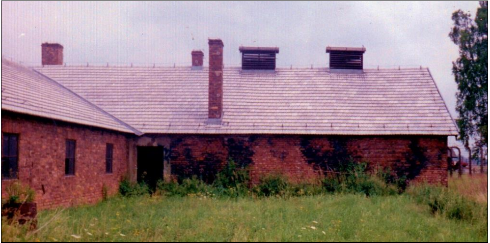
Abbildung 165: Entwesungstrakt des Bauwerks 5b, Südmauer mit intensiver Verfärbung. (© C. Mattogno 1992)
