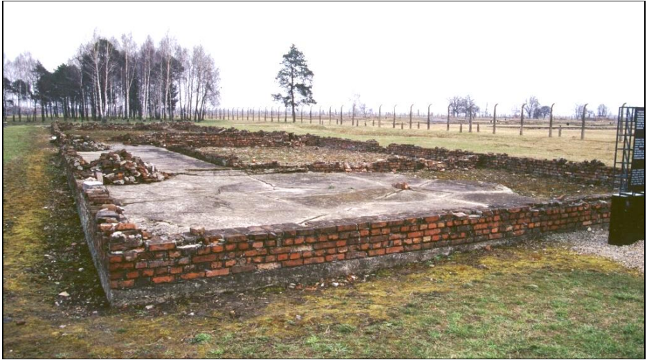
Abbildung 107: Ruine des Krematoriums IV mit vom Museum neu errichteten Grundmauern. (Dezember 1997)
