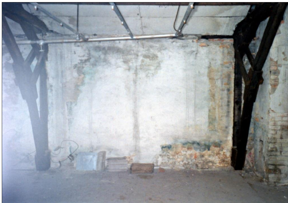
Abbildung 149a&b: Innenaufnahme des Entwesungstrakts des Bauwerks 5b, westlicher Teil der Südmauer. Der kalkreiche Innenverputz ist nur wenig verfärbt. Er ist in Bereichen abgefallen. Der drunter befindliche Mörtel ist weitaus stärker bläulich verfärbt, siehe die Nahaufnahme unten. (© C. Mattogno, Juli 1992)
