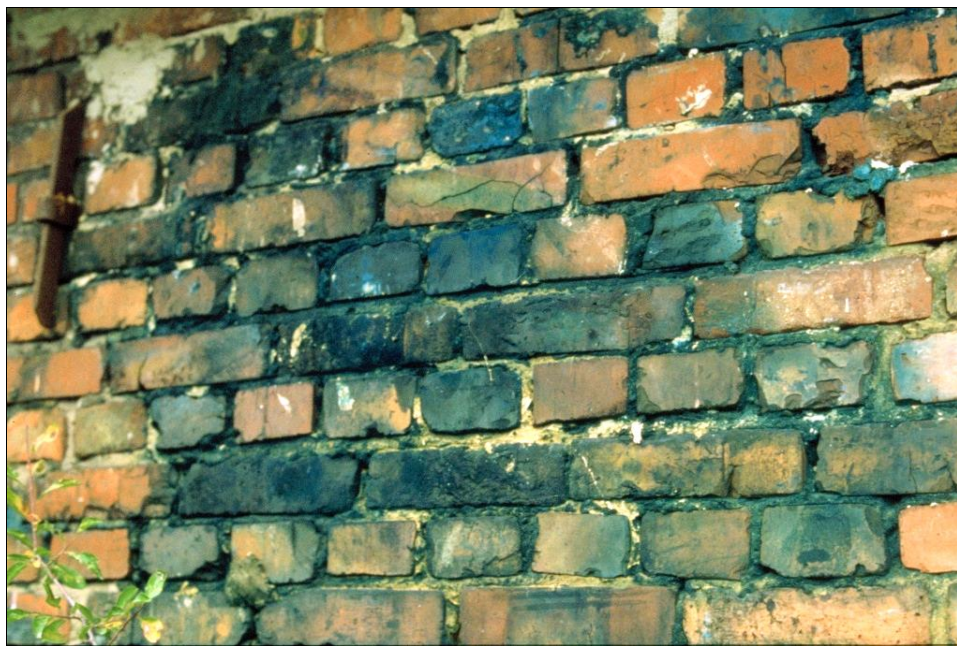
Abbildung 153: Detail der südlichen Außenwand des Bauwerks 5b. (Juli 1992)
