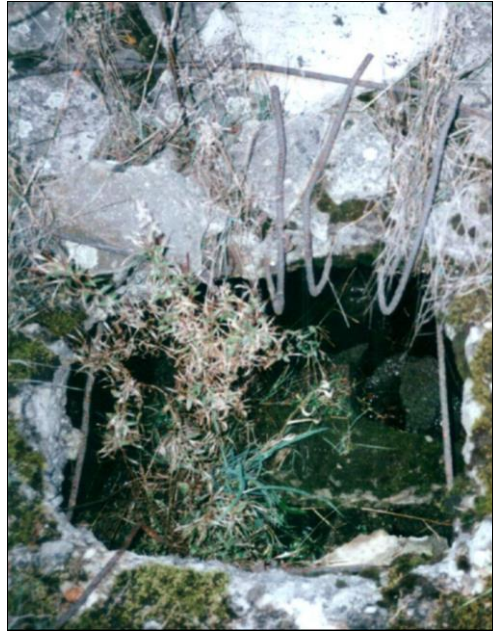
Abbildung 86: Loch in der Decke des Leichenkellers 1 (“Gaskammer”) vom Krematorium II. Es ist deutlich sichtbar, dass es nicht von den Bewehrungseisen des Stahlbetons befreit wurde. Diese wurden einfach nach hinten umgebogen. © Dez. 1991 Carlo Mattogno
