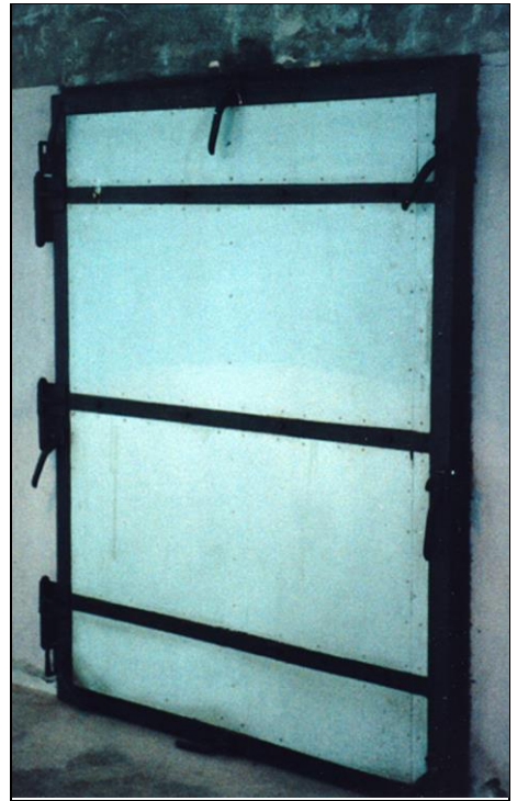
Abbildung 74: Gasdichte, ausbruchssichere Stahlrahmentür einer der DEGESH-Kreislauf-Entlausungsanlagen im Lager Buchenwald. (© C. Mattogno)
