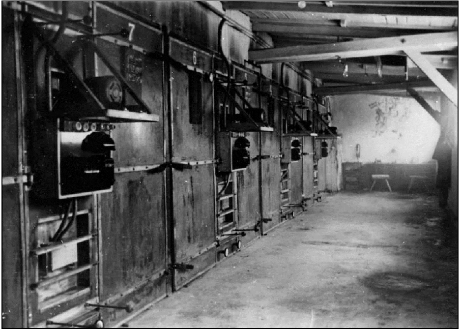
Abbildung 35: Vier Heißluftentwesungskammern in der Dusch- und Entlausungsbaracke des Zigeunerlagers, Birkenau (1943, Pressac 1989, S. 63).
