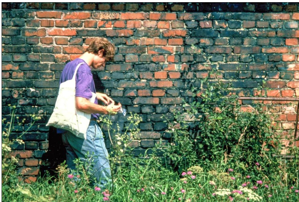
Abbildung 151: Im Gegensatz zum Bauwerk 5a (siehe Abbildungen 145, 167-169) wurde der Entwesungstrakt des Bauwerks 5b länger als Blausäure-Entwesungskammer benutzt. Dementsprechend ist dessen Außenmauer über große Flächen blau gefärbt, auch hier unbeeindruckt von 50 Jahren Witterungseinflüssen. Hier die Südwand (August 1991, mit dem Autor).
