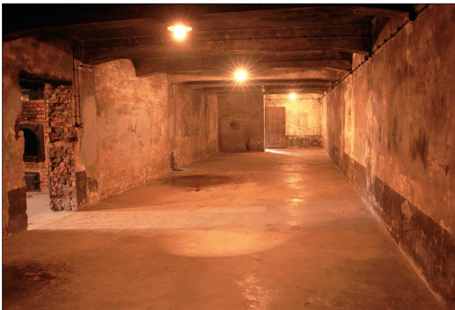
Abbildung 46: Raum im Krematorium I des Stammlagers Auschwitz, der heute als Menschengaskammer gezeigt wird ( history.com ). Vorne links: grob durchgebrochene Öffnung in der Mauer zum Ofenraum. Hintergrund links: Luftschleuse des Luftschutzbunkers von 1944.
