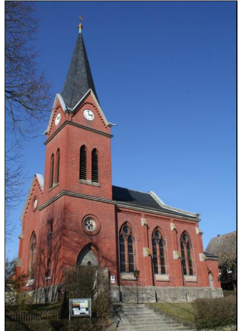
Abbildung 7: Im August 1976 wurde diese evangelische Kirche von D-96484 Meeder-Wiesenfeld (oben) mit Zyklon B begast. Anschließend verfärbte sich der Putz überall fleckig blau (vgl. Abbildung 9).
