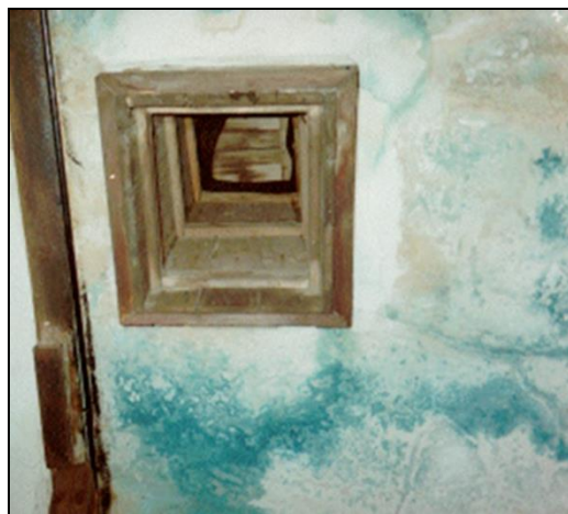
Abbildung 121: Große Zyklon-B Entwesungskammer, Decke neben einem der Lüftungsschächte, Baracke 41 im KL Majdanek. (Graf/Mattogno 2004, Farbfotos)
