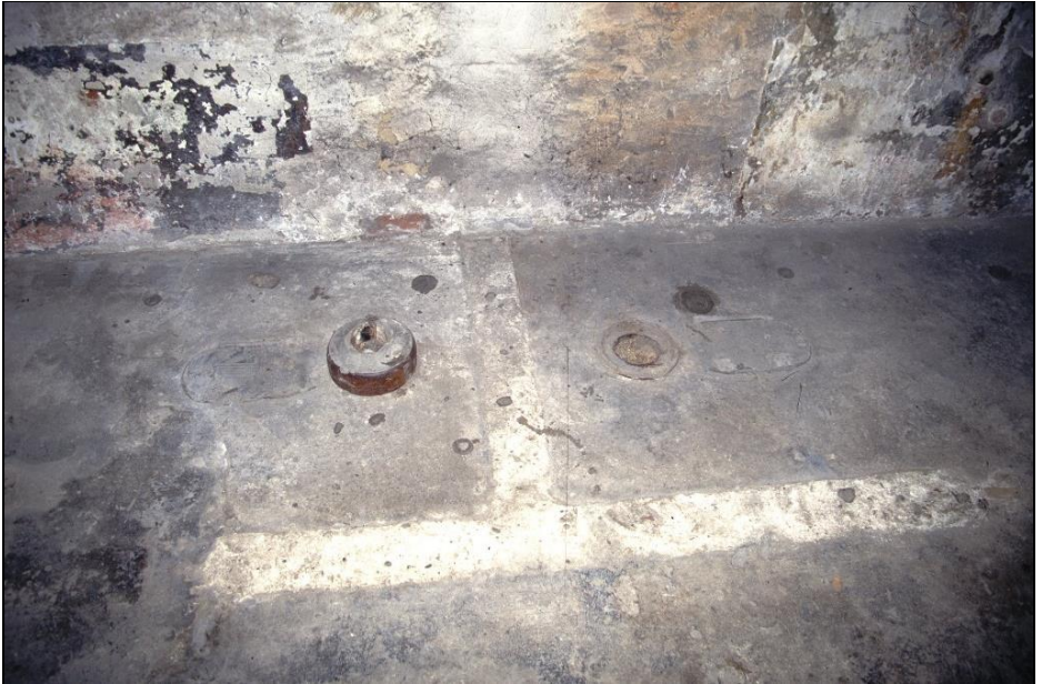
Abbildung 51: In der "Gaskammer" können die Besucher die Kloabflussrohre und die Spuren der Trennwände der Kabinen auf dem Boden bewundern, die aus der Zeit stammen, als das Krematorium als Luftschutzbunker diente.
