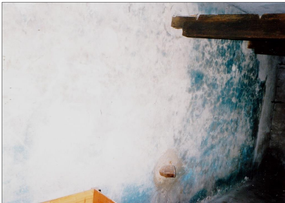
Abbildung 158: Entwesungstrakt des Bauwerks 5a, östliche Innenwand, nicht ganz so intensiv verfärbt wie die Außenwände (Raum 1 in Abbildung 41, von Norden gesehen). (© C. Mattogno 1992)
