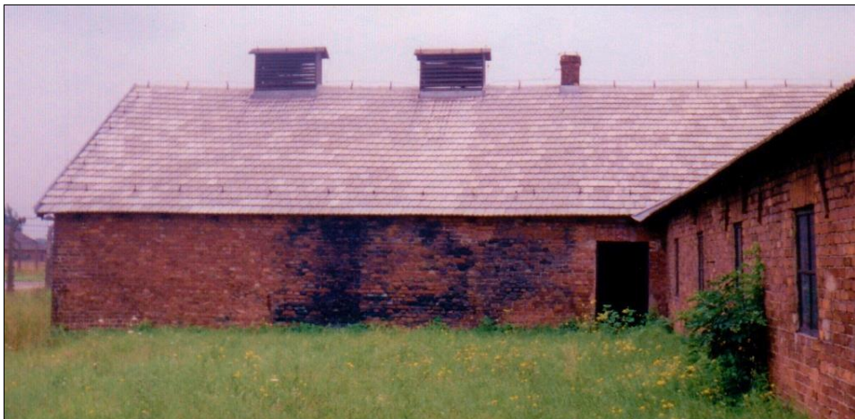
Abbildung 164: Entwesungstrakt des Bauwerks 5b, Nordmauer mit intensiver Verfärbung. (© C. Mattogno 1992)
