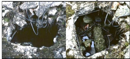
Abbildungen 87 & 88: Das gleiche Loch wie zuvor, Foto vom Feb. 1997 von Dr. Fredrick Töben. Links: vor seinem Versuch, die Bewehrungseisen zurückzubiegen. Rechts: nach diesem Versuch, mit beiden Eisenstäben abgebrochen am Boden des Lochs liegend.
