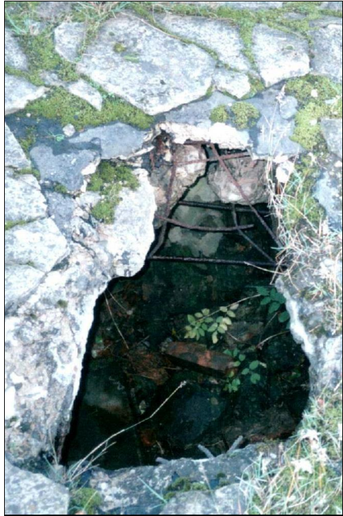
Abbildung 84: Loch in der Decke des Leichenkellers 1 ("Gaskammer") vom Krematorium II, Einstieg zum noch heute begehbaren Teil des Kellers. Maximale Breite: 50 cm; maximale Länge: 86 cm. © 1992 Carlo Mattogno
