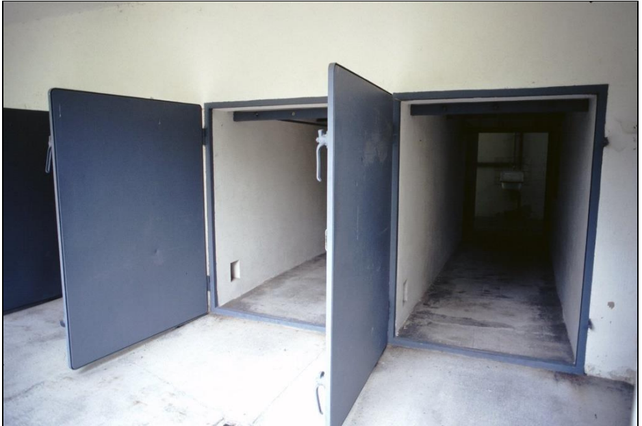
Abbildung 72: Gasdichte, ausbruchsichere Stahltüren der DEGESCH-Kreislauf-Entlausungsanlagen im Lager Dachau. (1998)
