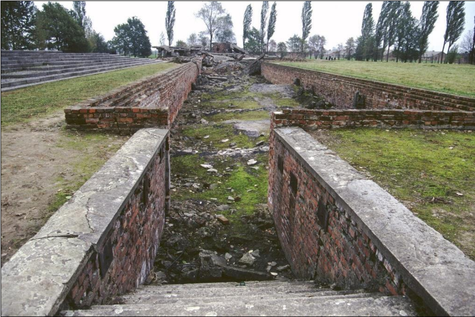
Abbildung 69: Leichenkeller 2 des Krematoriums II (Februar 1997).
