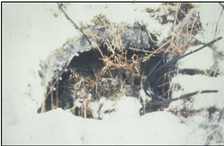
Abbildung 8: Angebliches Zyklon-B-Einwurfloch in der Decke des Leichenkellers I ('Gaskammer') vom Krematorium II. Es ist deutlich sichtbar, dass es nicht von den Bewehrungsseisen des Stahlbetons befreit wurde. Diese wurden einfach nach hinten umgebogen.
