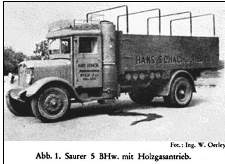
Abbildung 4: Ein weiterer deutscher Holzgaslaster der Fa. Saurer (Typ 5 BHw) aus der Kriegszeit.
