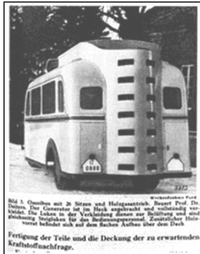
Abbildung 8: Deutscher Generatorgas-Omnibus der Kriegszeit.
