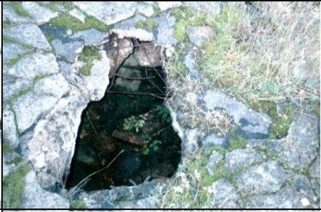
Abbildung 7: Angebliches Zyklon-B-Einwurfloch in der Decke des Leichenkellers I ('Gaskammer') vom Krematorium II, Einstieg zum noch heute begehbaren Teil des Kellers.
