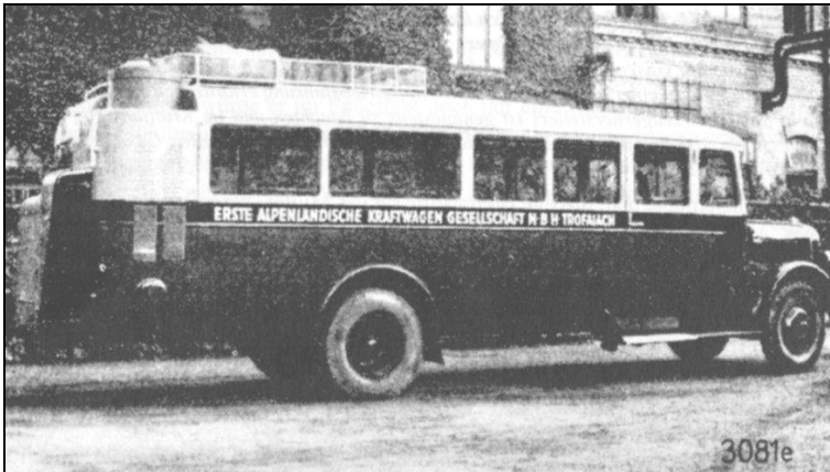
Abbildung 1: Ein typischer Gaswagen, der ursprünglich ein normaler Omnibus war, aber nachträglich mit einem Generator und einem Saurer-Motor ausgerüstet wurde. 127
